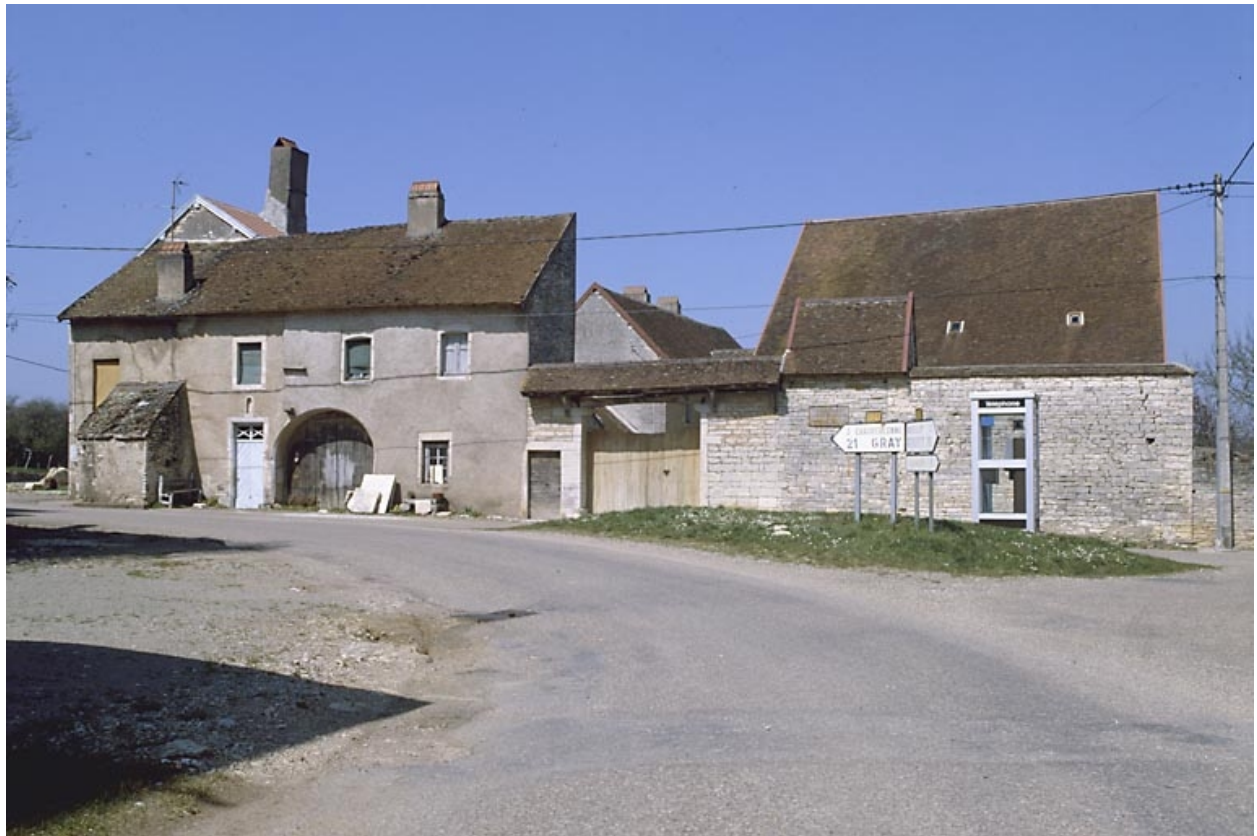
Vue d'ensemble après destruction du bâtiment agricole.
