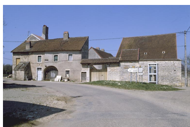
Vue d'ensemble après destruction du bâtiment agricole. Phot. Yves Sancey IVR43_19857000051XA
