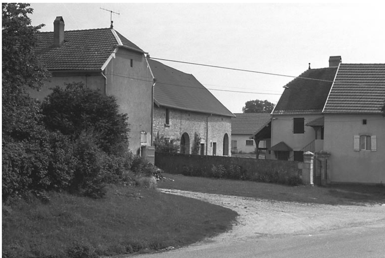
Ferme située rue du Vieux Moulin.
