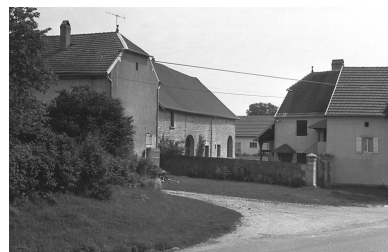
Ferme située rue du Vieux Moulin. Phot. Bernard Lardière IVR43_19817000248Z
