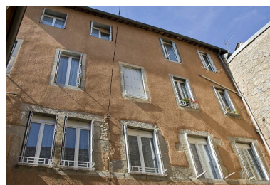
Logis principal : vue d'ensemble de la façade postérieure. Phot. Yves Sancey IVR43_20112502897NUC2A
