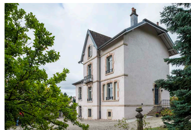
Le mur pignon nord. Phot. Jérôme Mongreville IVR43_20177001100NUC4A
