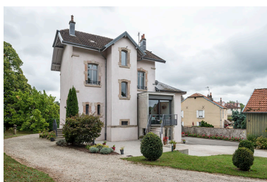
Façade postérieure. Phot. Jérôme Mongreville IVR43_20177001104NUC4A
