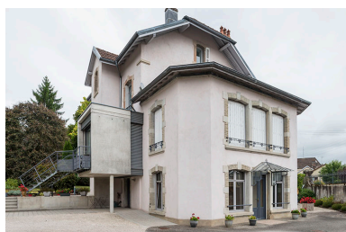
Le mur pignon sud avec l'agrandissement réalisé par la famille Petit. Phot. Jérôme Mongreville IVR43_20177001103NUC4A
