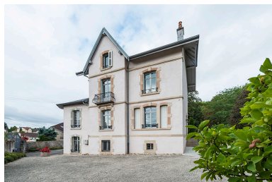
Vue générale. Phot. Jérôme Mongreville IVR43_20177001099NUC4A
