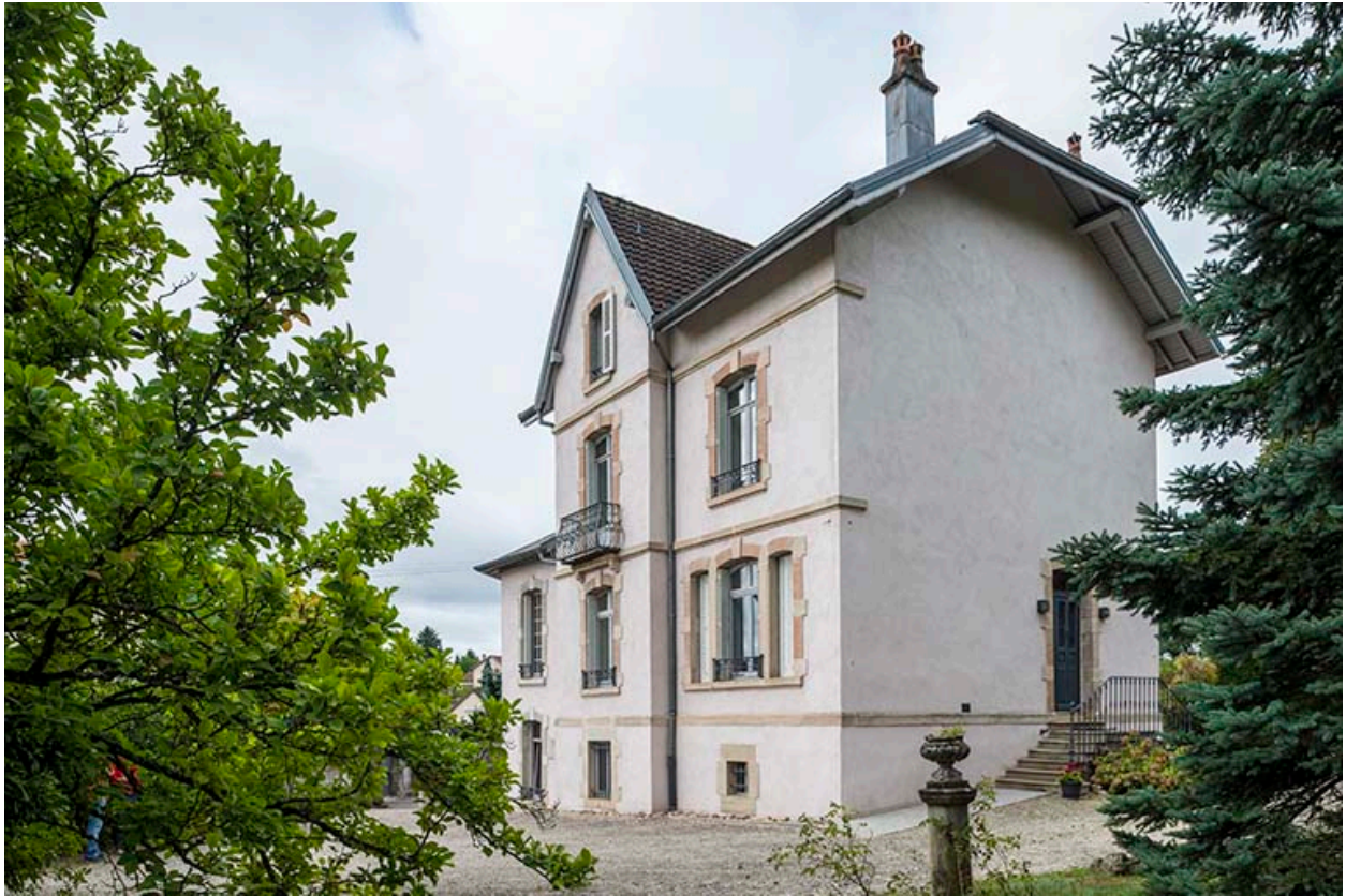
Le mur pignon nord.
