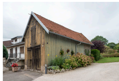
Le bâtiment à usage de garage. Phot. Jérôme Mongreville IVR43_20177001102NUC4A
