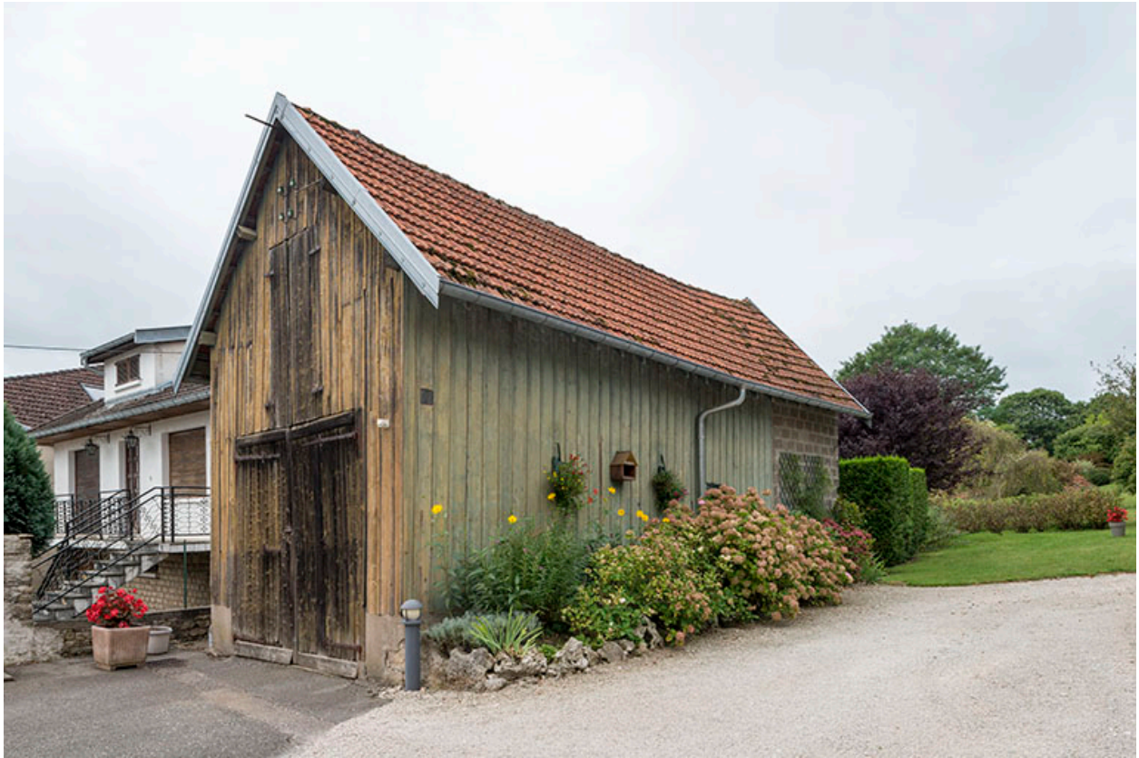
Le bâtiment à usage de garage.
