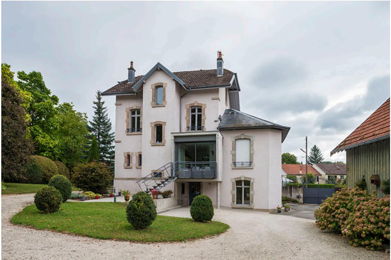
L'extension en béton.
