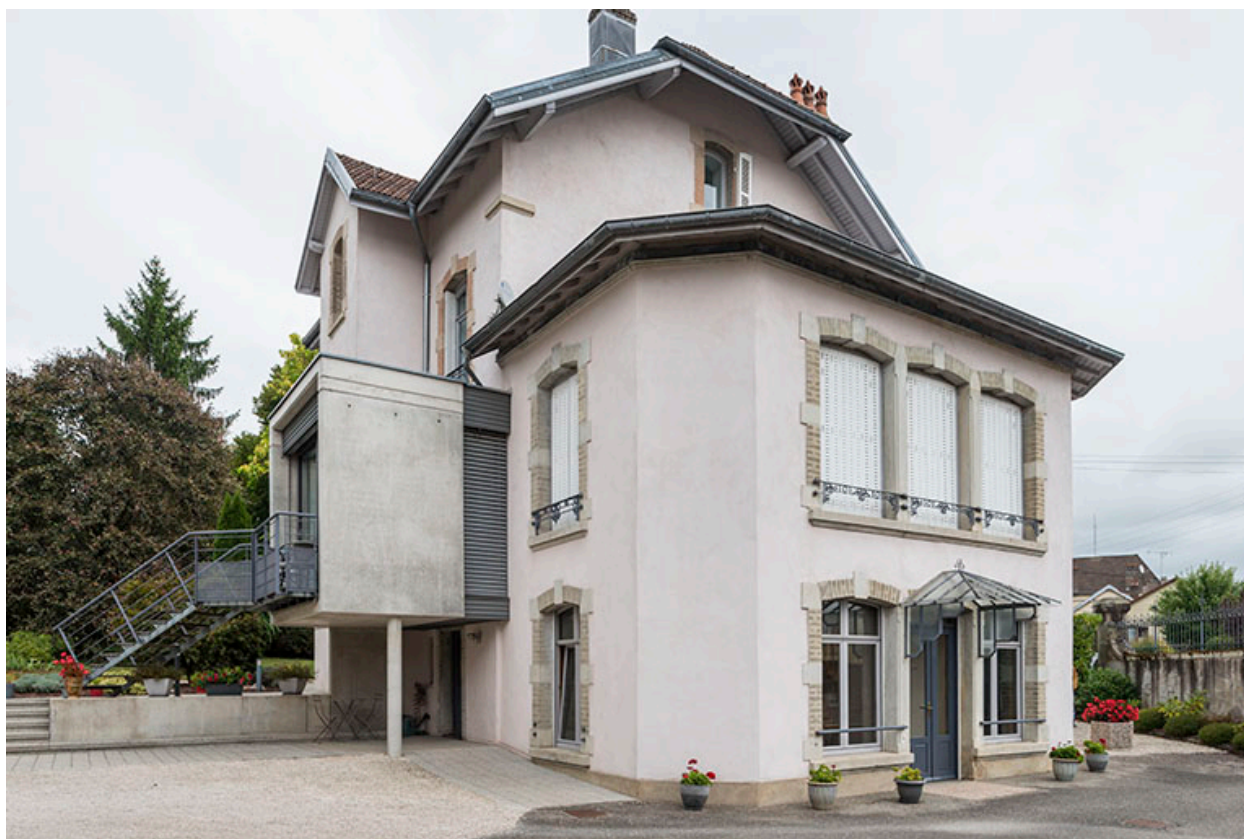
Le mur pignon sud avec l'agrandissement réalisé par la famille Petit.
