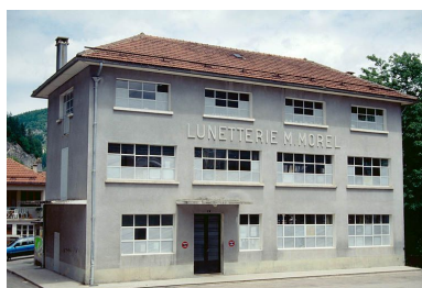
Ancien atelier du celluloïd (lunetterie M. Morel). Phot. Laurent Poupard IVR43_19913901448ZA
