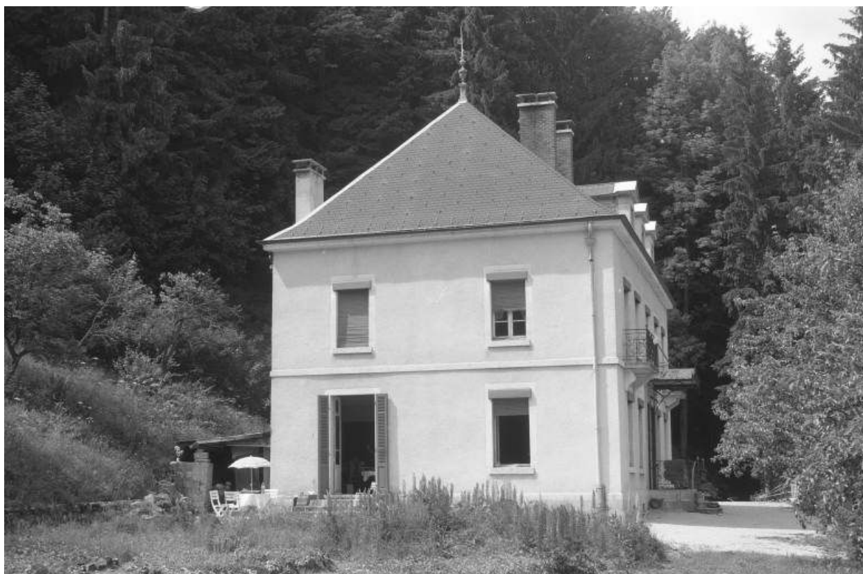
Façade latérale gauche du logement patronal.
