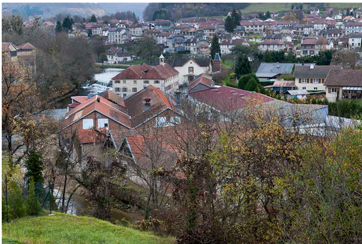
Vue plongeante depuis l'ouest.
