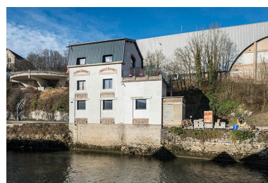
Transformateur. Façade sud.
