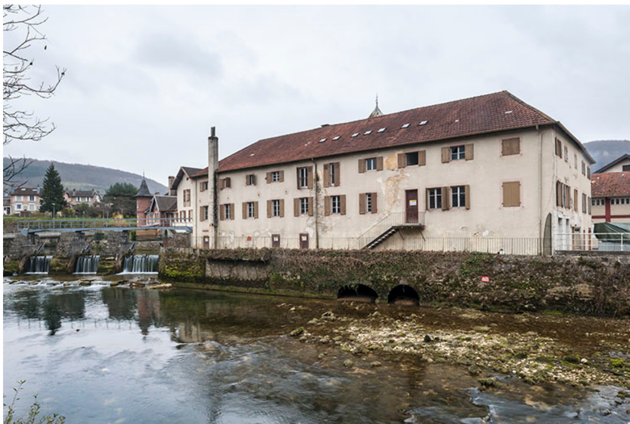
Façade nord du bâtiment du moulin.
