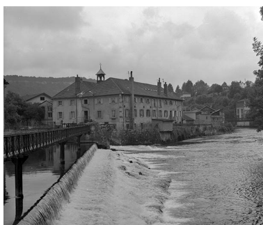
Atelier de fabrication depuis la rive droite du barrage en 1981. Phot. Yves Sancey IVR43_19812500326X
