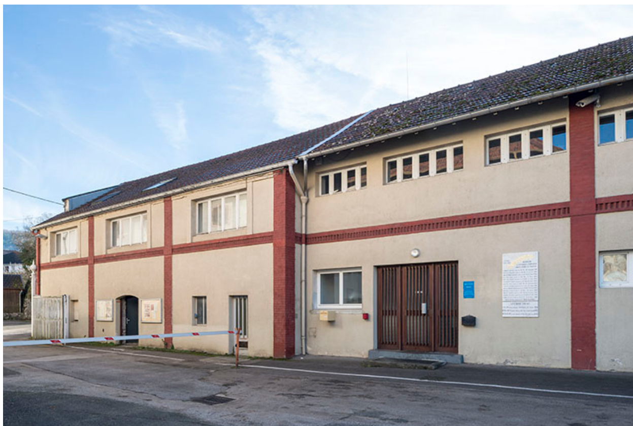
Bureaux et bâtiment à vocation sociale.
