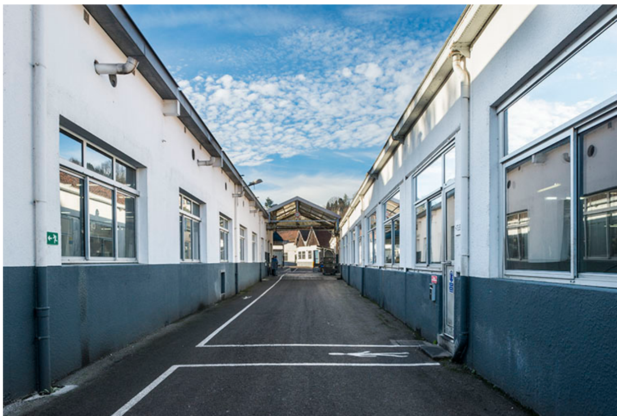
Passage entre deux ateliers. Vue depuis l'ouest.
