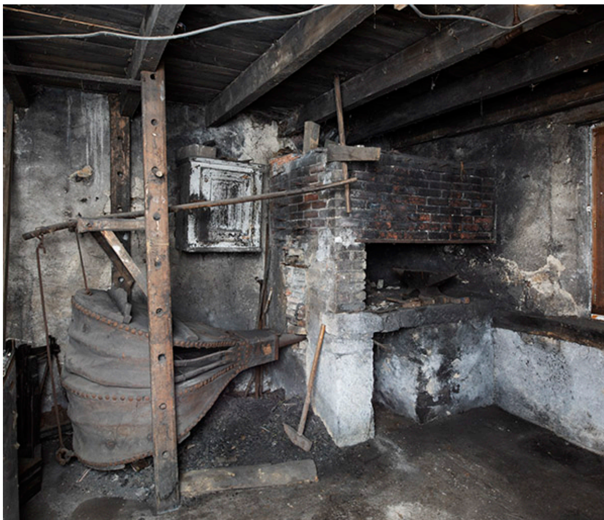
Forge : soufflet, foyer et établi (à droite).
