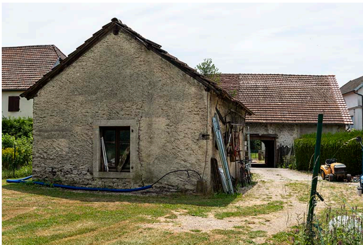
Forge : façade postérieure, de trois quarts droite.
