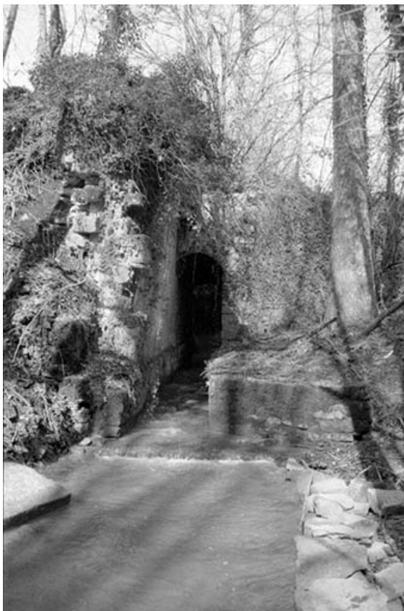
Coursière au débouché du bassin de retenue.
