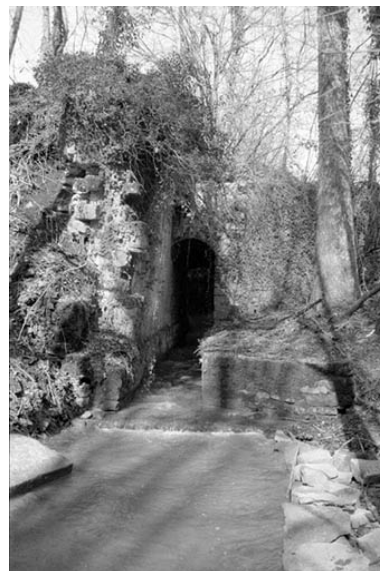
Coursière au débouché du bassin de retenue. Phot. Laurent Poupard IVR43_19883900273Z
