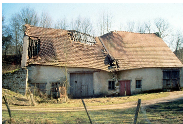
Façade antérieure de l'ancienne halle à charbon. Phot. Laurent Poupard IVR43_19883900274ZA
