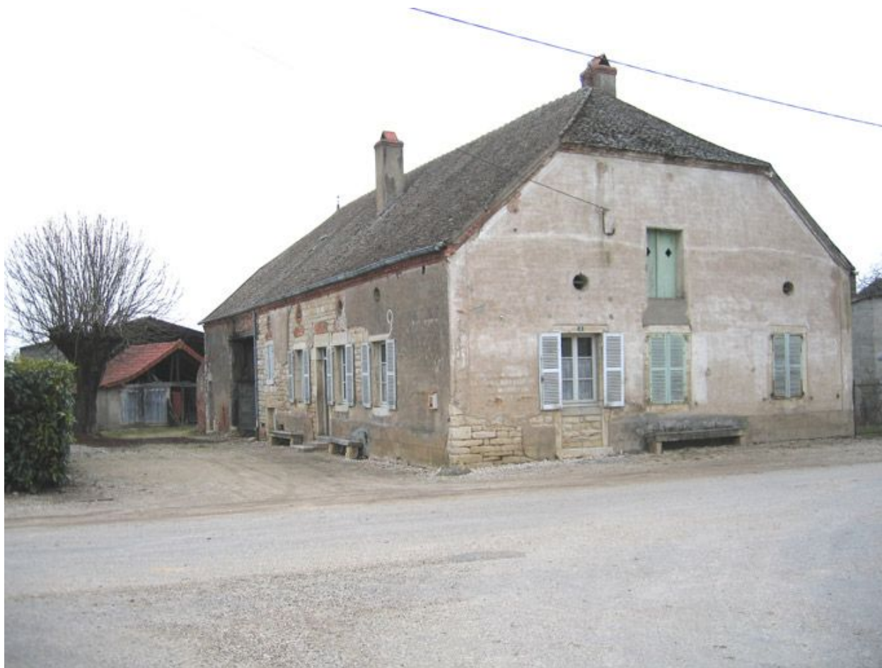
Vue d'ensemble de la façade.
