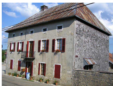
Maison commune, puis école primaire, puis café, actuellement maison. Phot. Marie-Pierre Reynet IVR43_20083900027NUC1A
