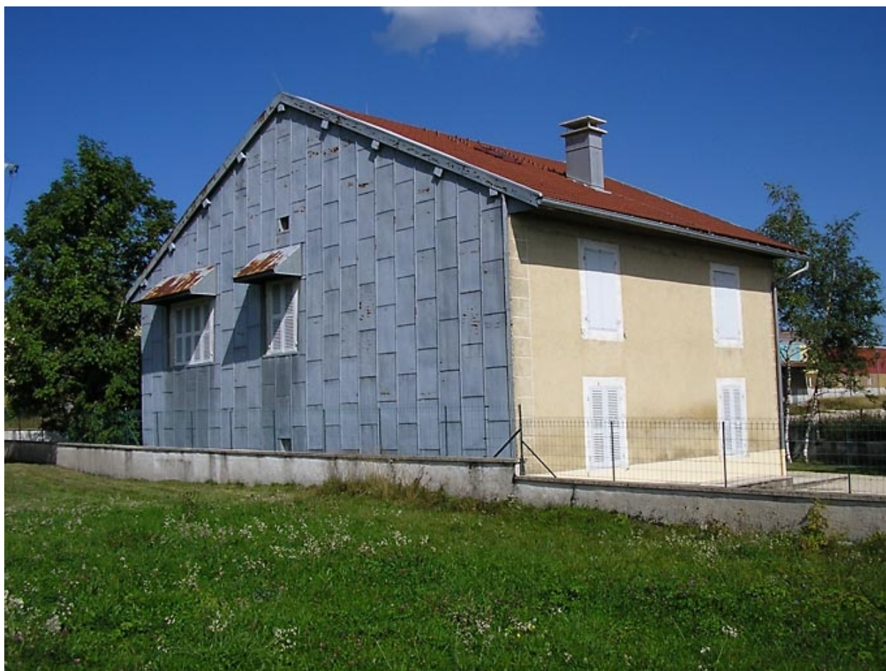
Maison située 4 Grande Rue, au lieu-dit Les Dadonnins.
