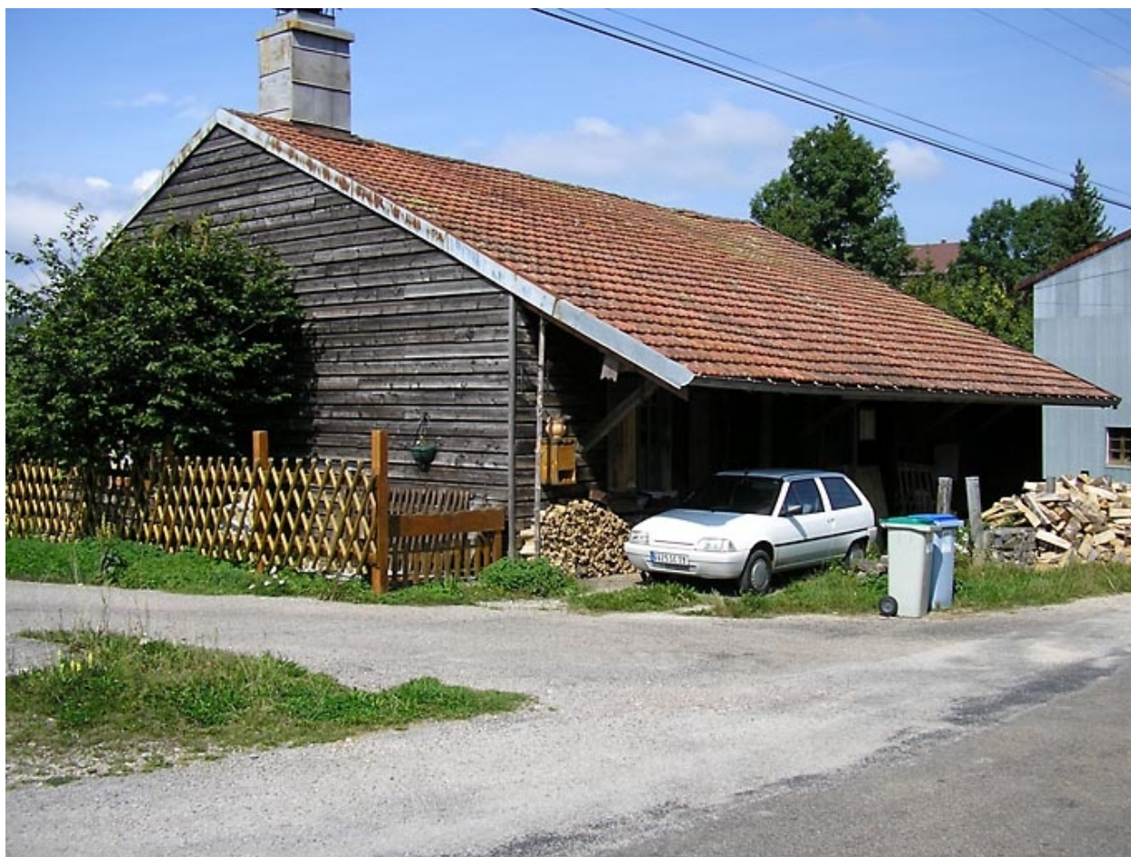
Fromagerie, actuellement maison située au lieu-dit les Bouvets d'Amont.
