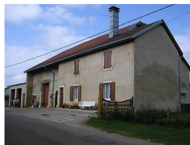
Ferme située 61 Grande Rue, au lieu-dit Les Bouvets d'Aval. Phot. Marie-Pierre Reynet IVR43_20083900041NUC1A
