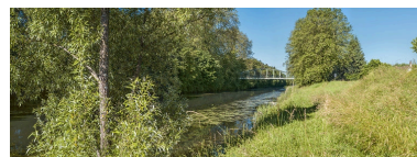
Vue d'ensemble du pont et de la dérivation. Phot. Thierry Kuntz IVR26_20162101266NUC4A
