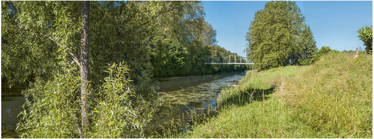
Vue d'ensemble du pont et de la dérivation.
