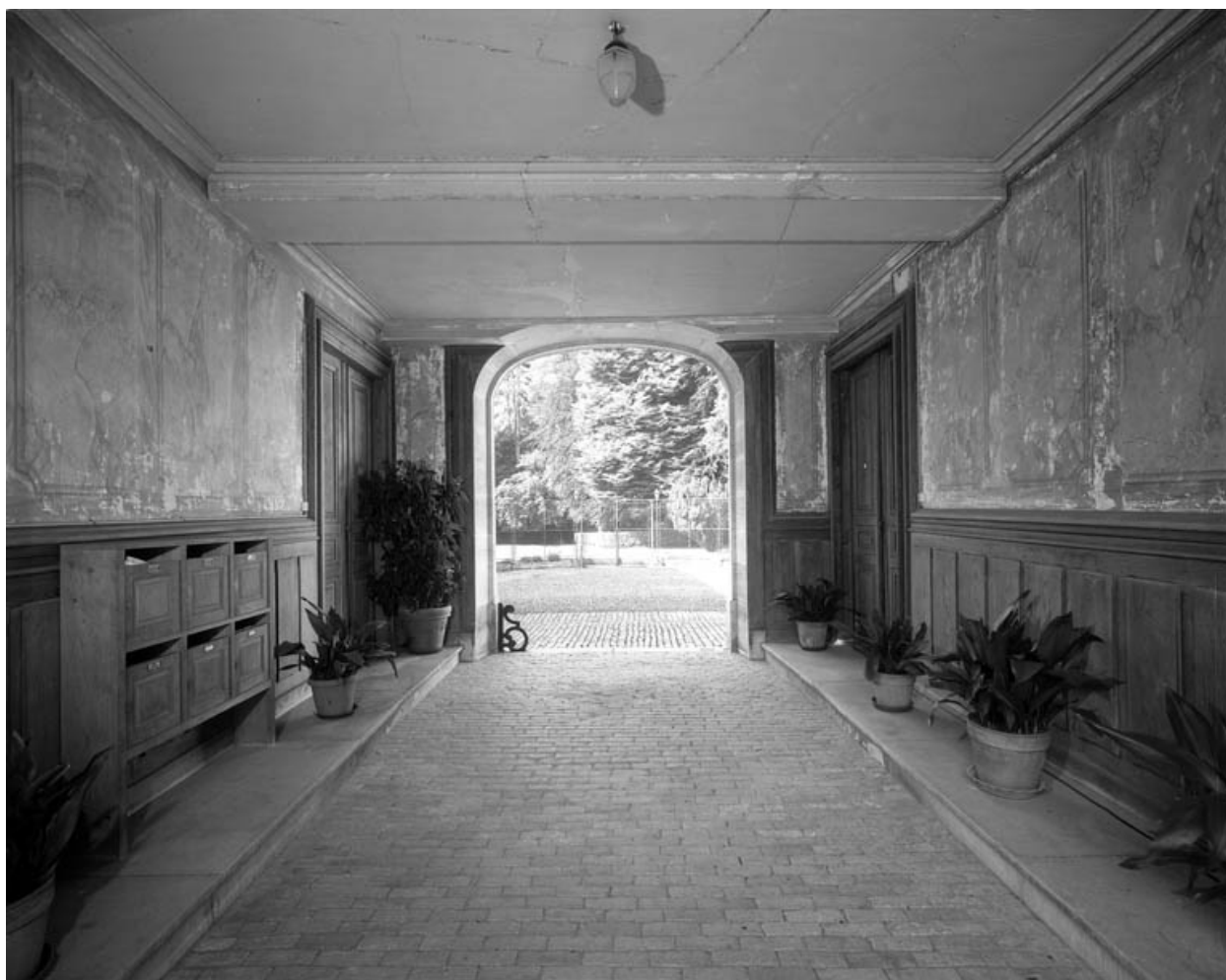
Détail du vestibule depuis la porte d'entrée.
