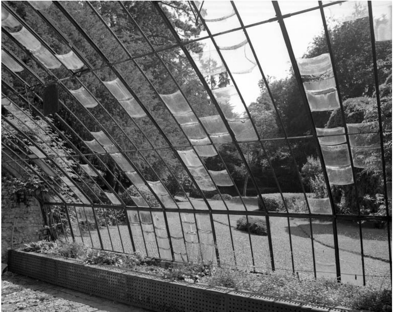
Serre : détail de la verrière.
