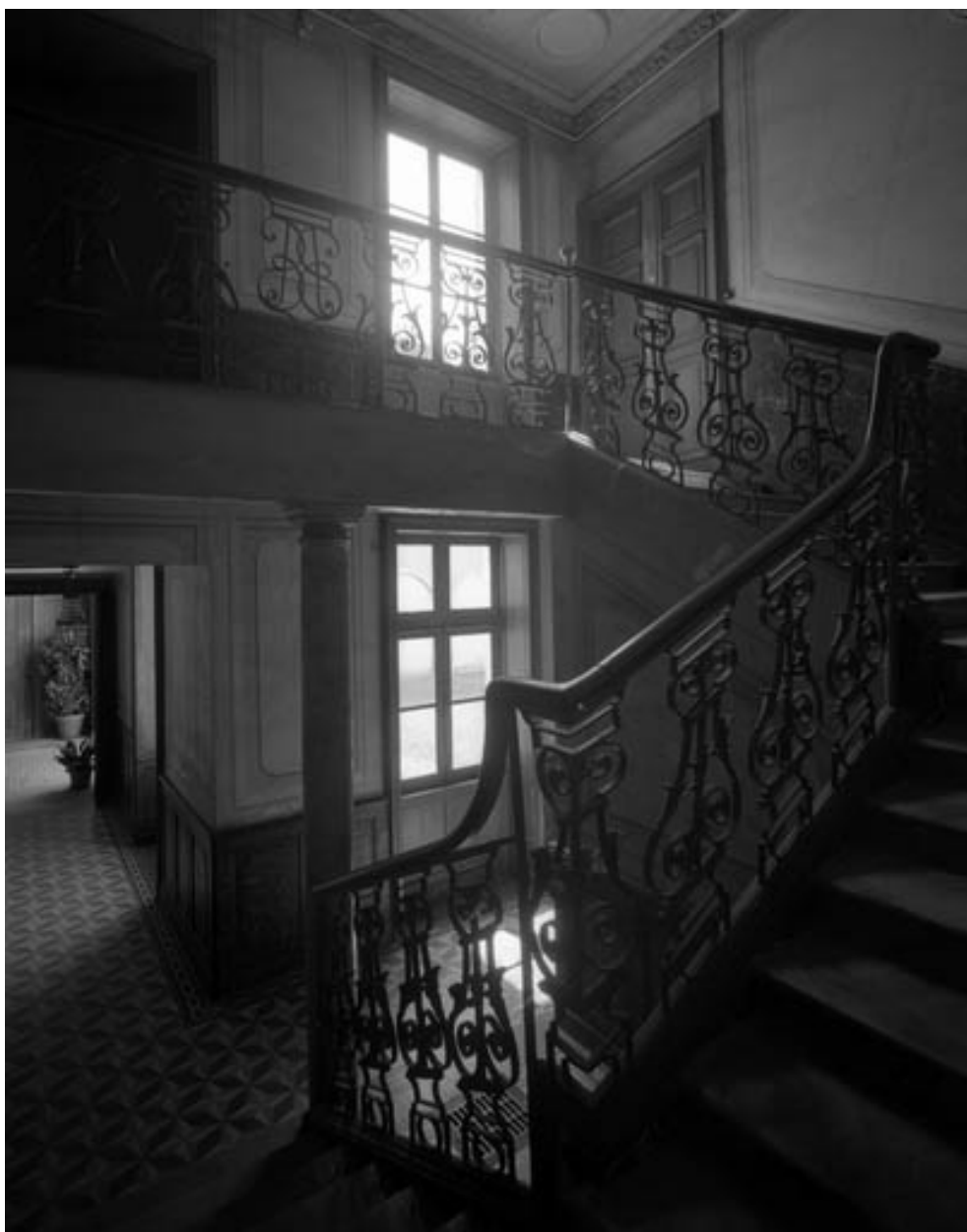
Escalier d'honneur : vue d'ensemble.
