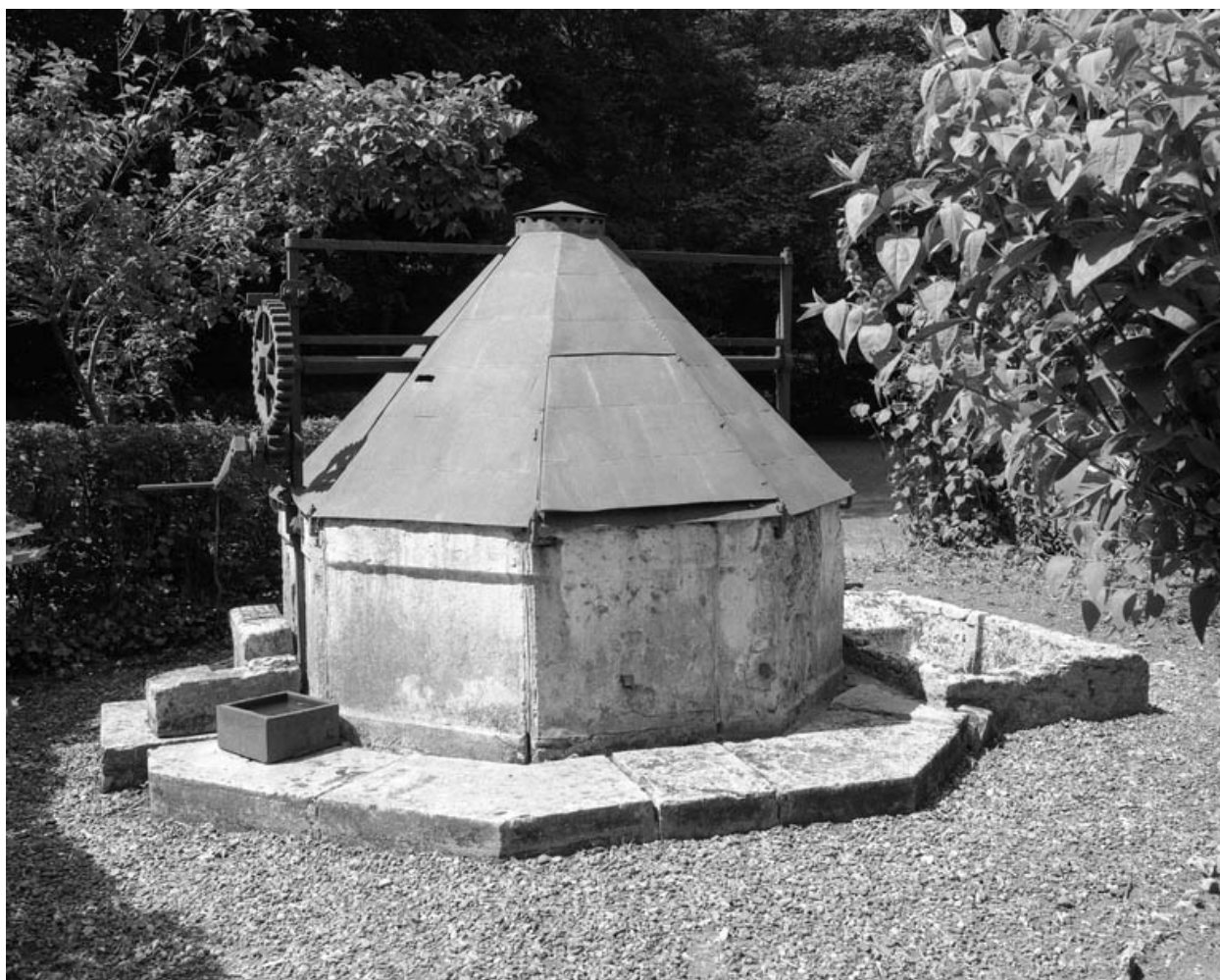
Détail du puits situé dans le parc.
