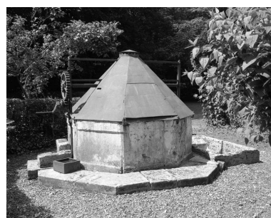
Détail du puits situé dans le parc. Phot. Yves Sancey IVR43_19917000369X
