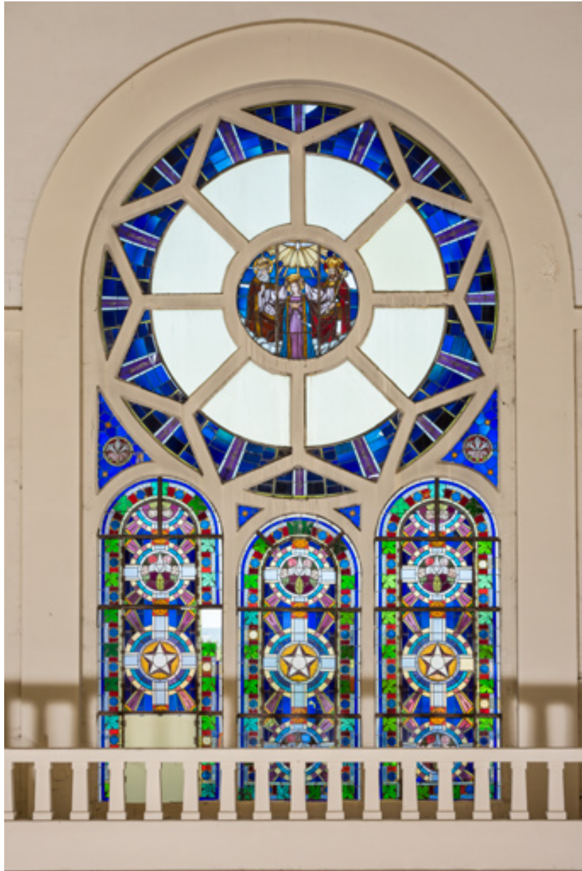
Verrière de la baie 101. Vue d'ensemble.
