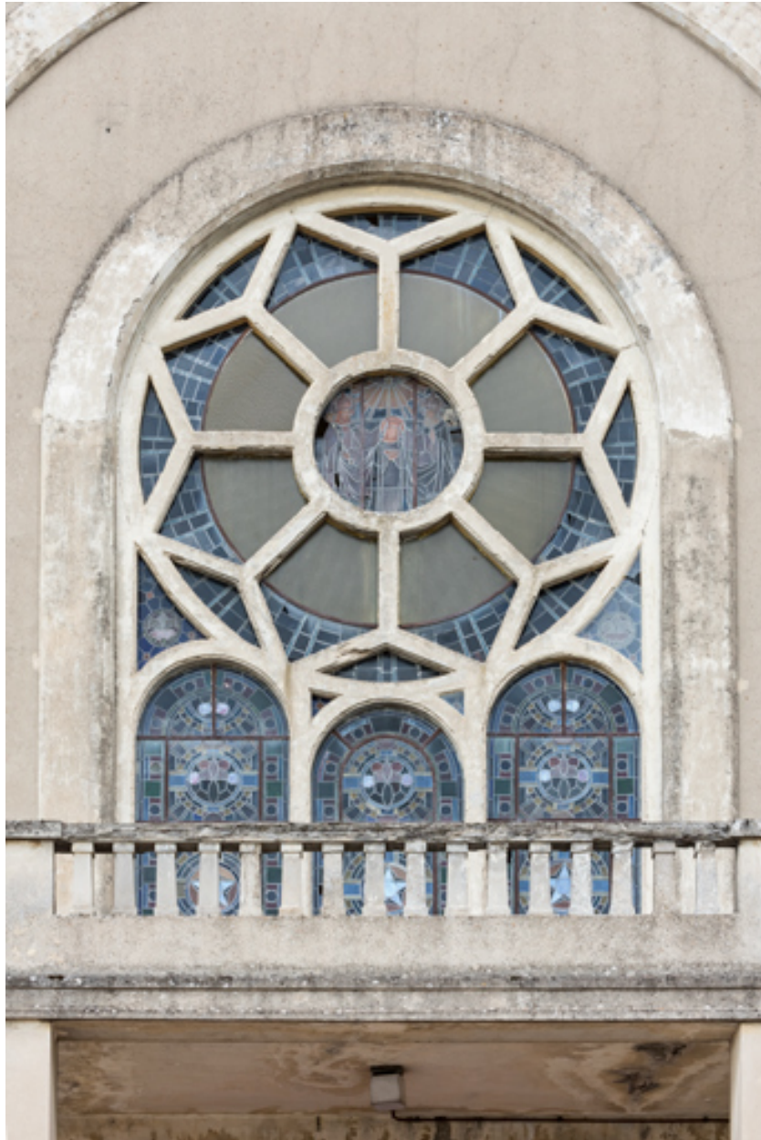
Verrière de la façade ouest. Vue extérieure.
