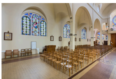
Verrières de la façade est (Baies 104, 106, 108 et 110). Vue d'ensemble de trois quarts. Phot. Pierre-Marie Barbe-Richaud IVR26_20238901186NUC4A
