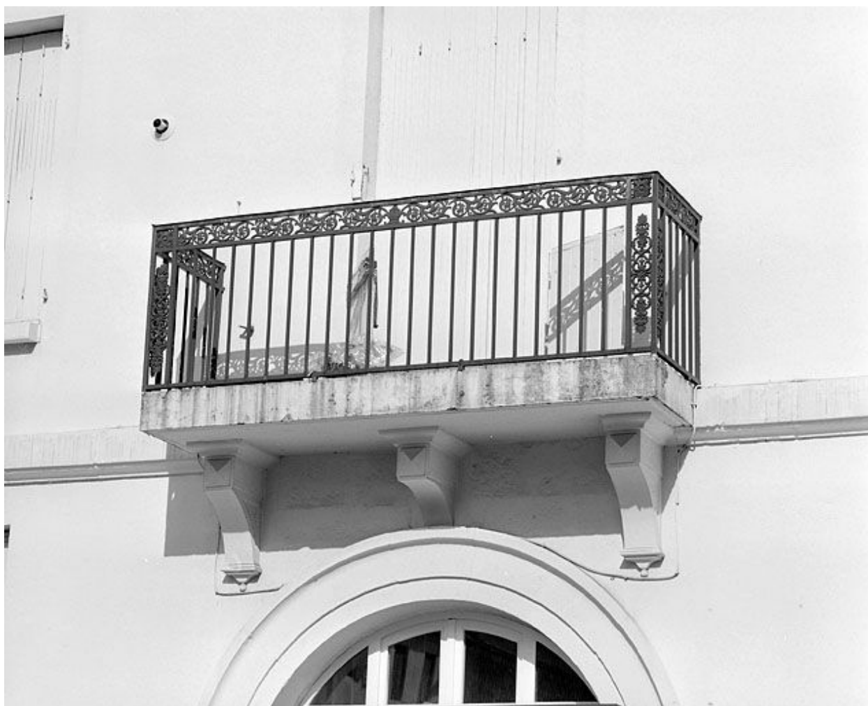
Façade latérale droite : balcon du premier étage.
