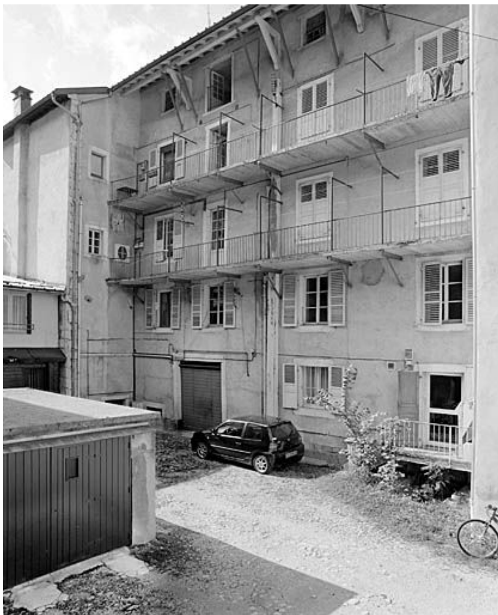
Façade postérieure du n° 143.
