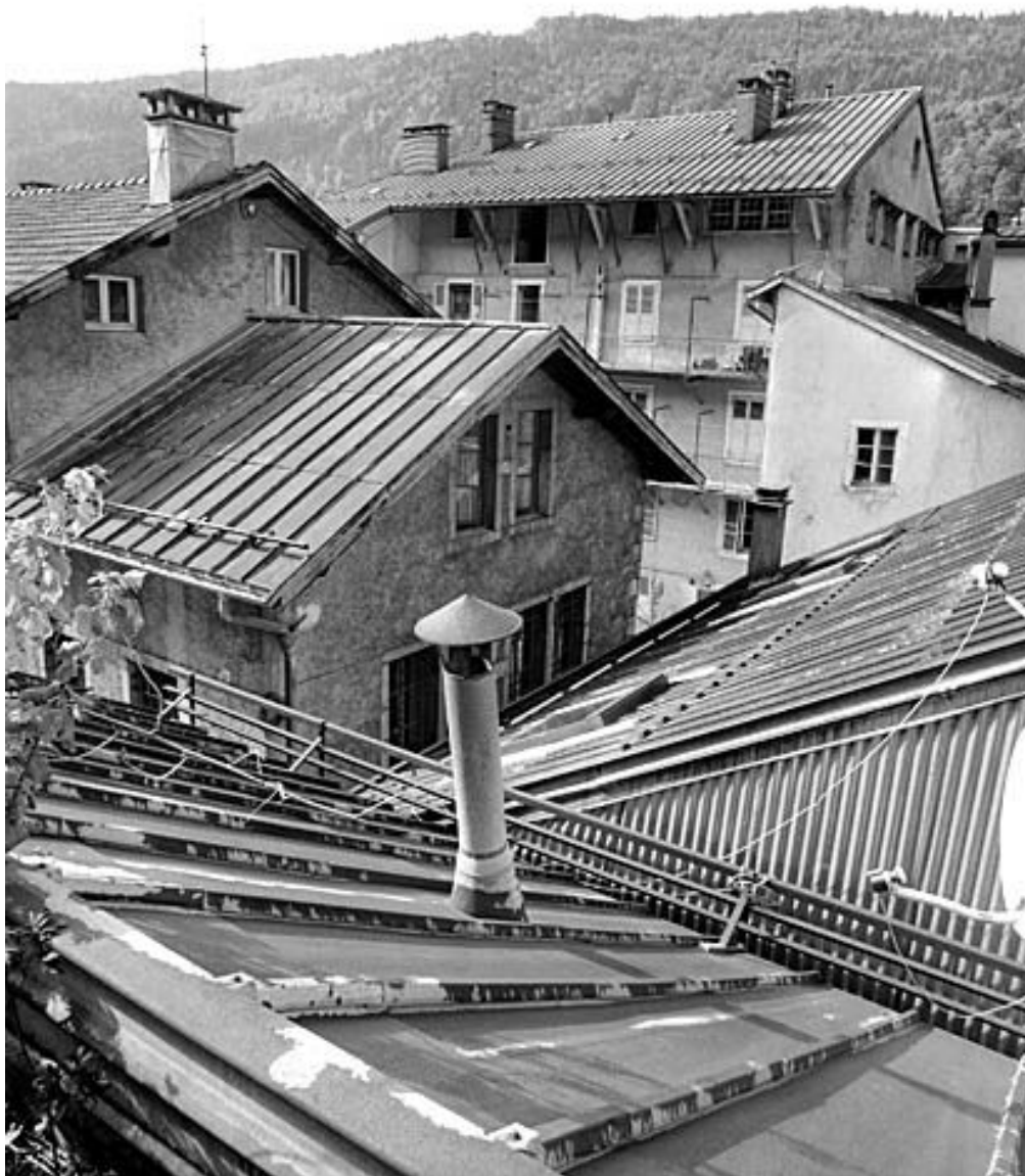
Toitures des bâtiments est et nord-est.
