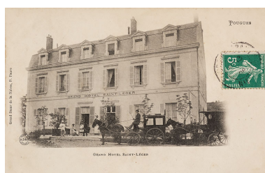
Façade avant l'ajout d'un second étage carré. Autr. auteur inconnu IVR26_20205800065NUC4A
