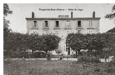
Façade après l'ajout d'un second étage carré. Autr. auteur inconnu IVR26_20195800768NUC4A
