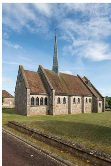
Élévation ouest, vue de trois quarts. Phot. Pierre-Marie Barbe-Richaud IVR26_20238901117NUC4A
