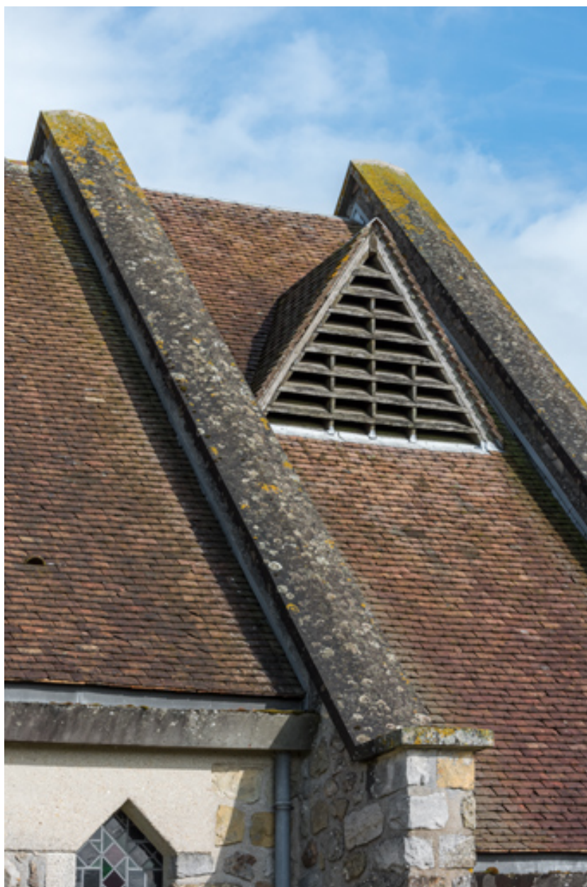
Toiture du porche, détail de la lucarne close par des abat-sons.
