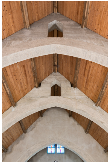
Charpente, détail des arcs. Phot. Pierre-Marie Barbe-Richaud IVR26_20248900133NUC4A
