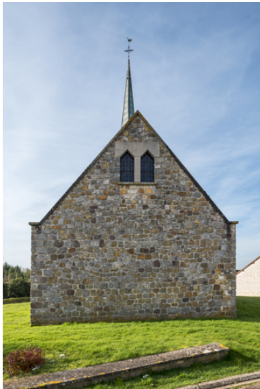
Chevet. Phot. Pierre-Marie Barbe-Richaud IVR26_20248900128NUC4A
