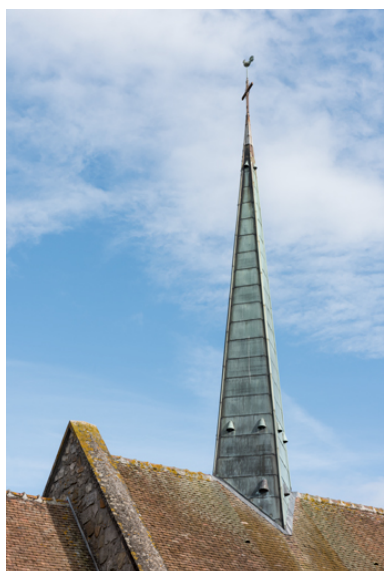
Flèche polygonale en cuivre. Phot. Pierre-Marie Barbe-Richaud IVR26_20238901118NUC4A
