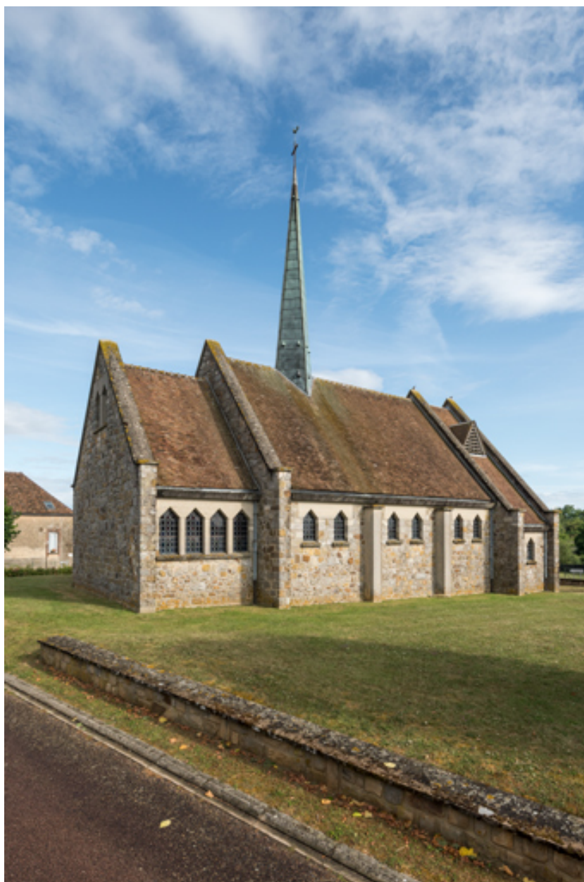
Élévation ouest, vue de trois quarts.
