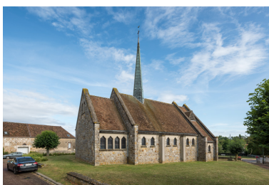
Elévations ouest, vue d'ensemble. Phot. Pierre-Marie Barbe-Richaud IVR26_20238901116NUC4A
