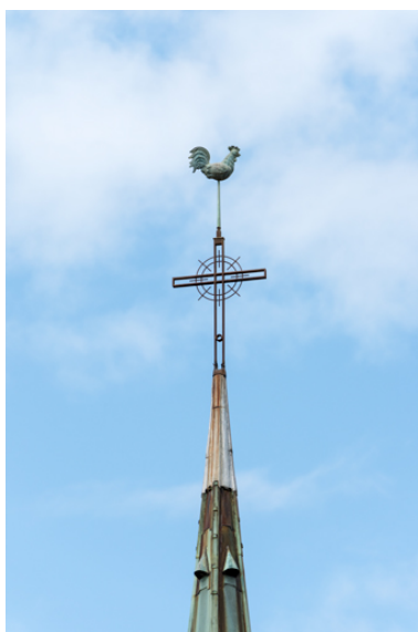
Flèche, détail de la croix et du coq. Phot. Pierre-Marie Barbe-Richaud IVR26_20238901109NUC4A
