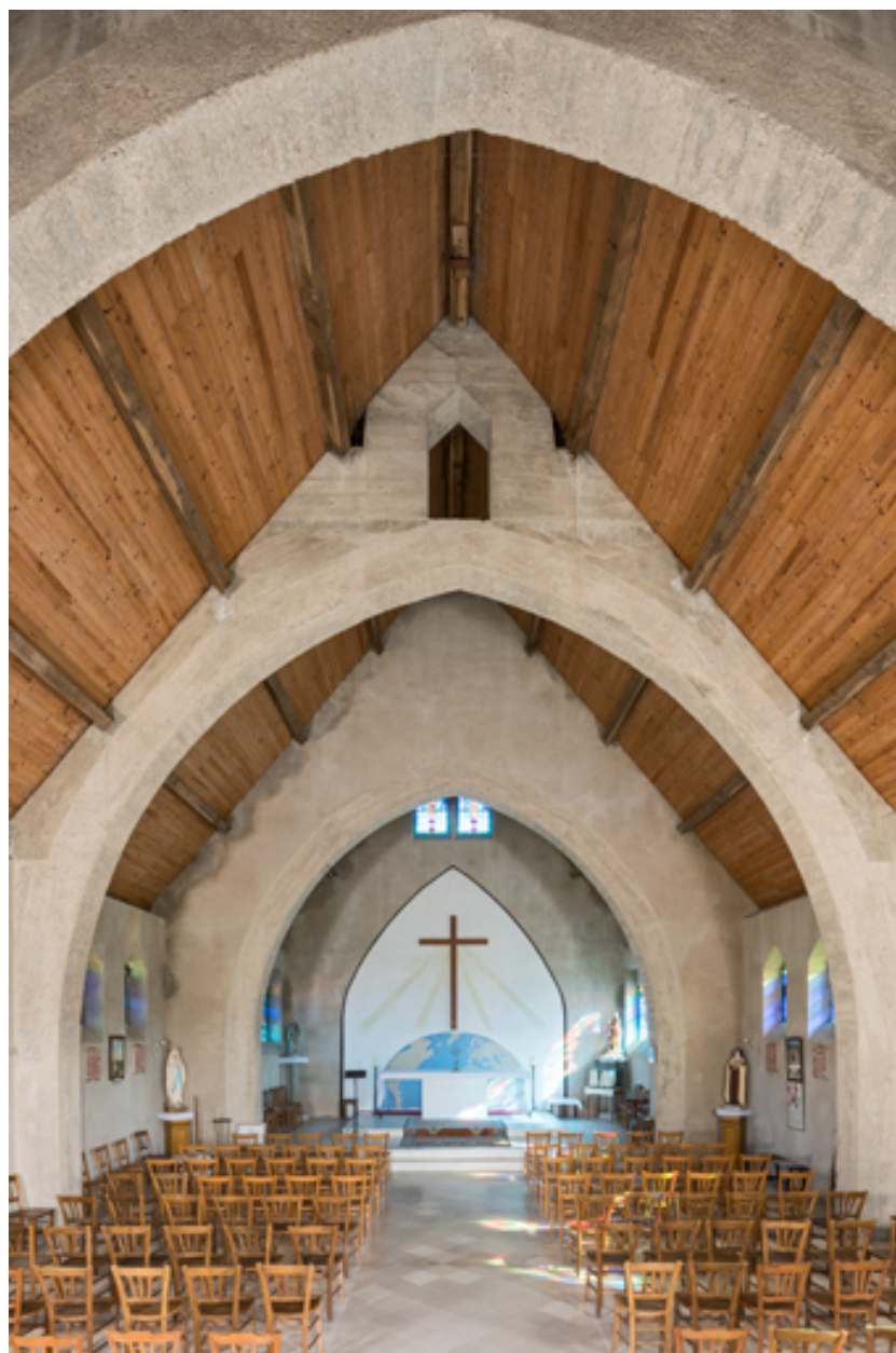
Nef, vue en direction du chœur.
