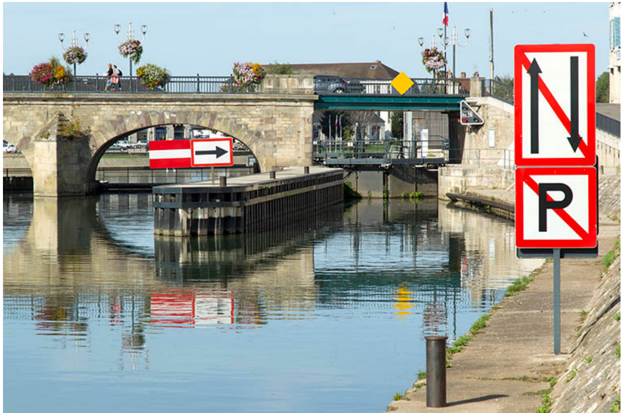
L'écluse, vue amont.
