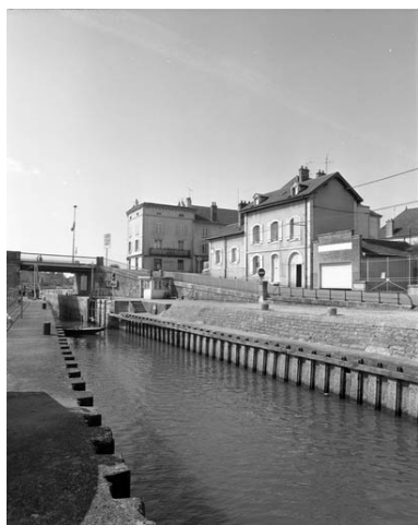
L'écluse, quay Vergy, avec la maison de l'éclusier. Phot. Yves Sancey IVR43_19887000066X
