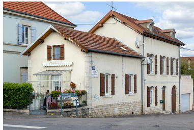
Maison de l'éclusier. Phot. Sonia Dourlot IVR43_20157000872NUC2A
