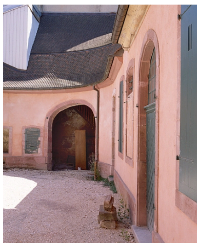
Aile droite dans la cour. Phot. Jérôme Mongreville IVR43_19882500174XA
