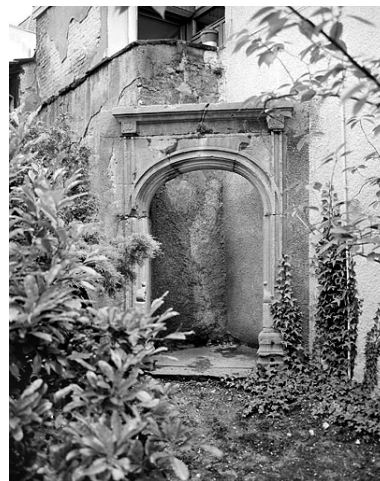
Portail provenant d'une maison détruite rue du Château. Phot. Jérôme Mongreville IVR43_19872501275X
