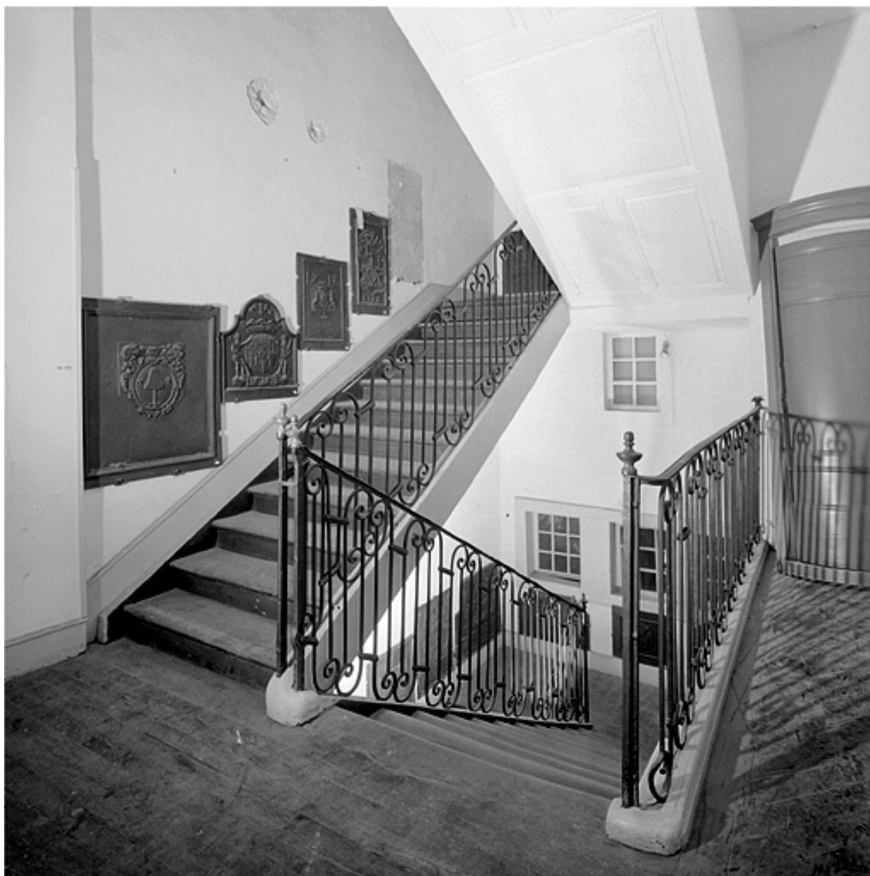
Escalier vu du palier du premier étage.
