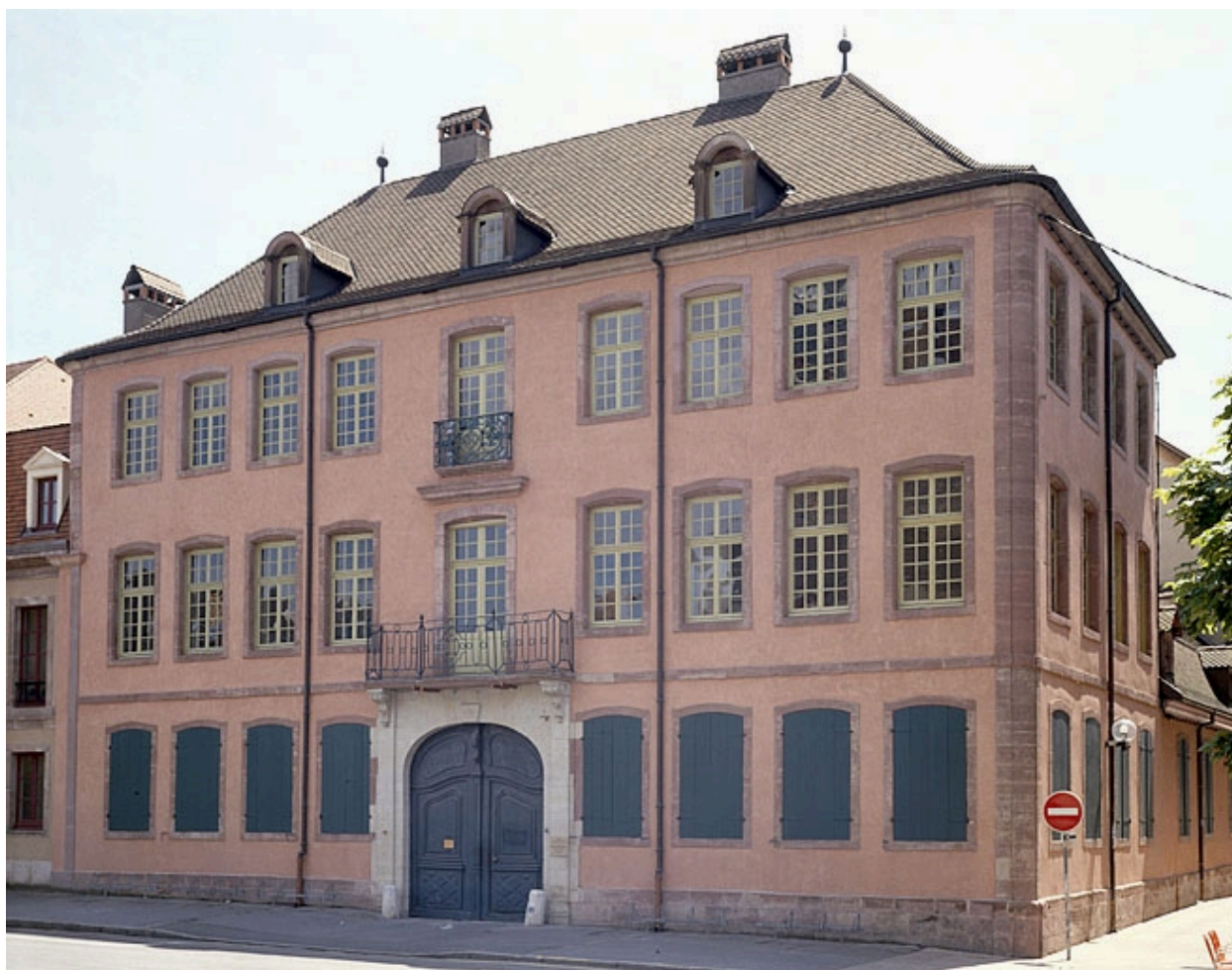
Façade principale sur la place Saint-Martin.
