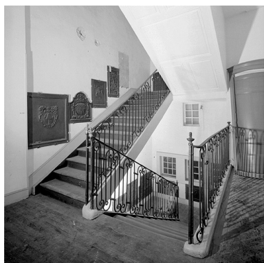
Escalier vu du palier du premier étage. Phot. Jérôme Mongreville IVR43_19882500142V
