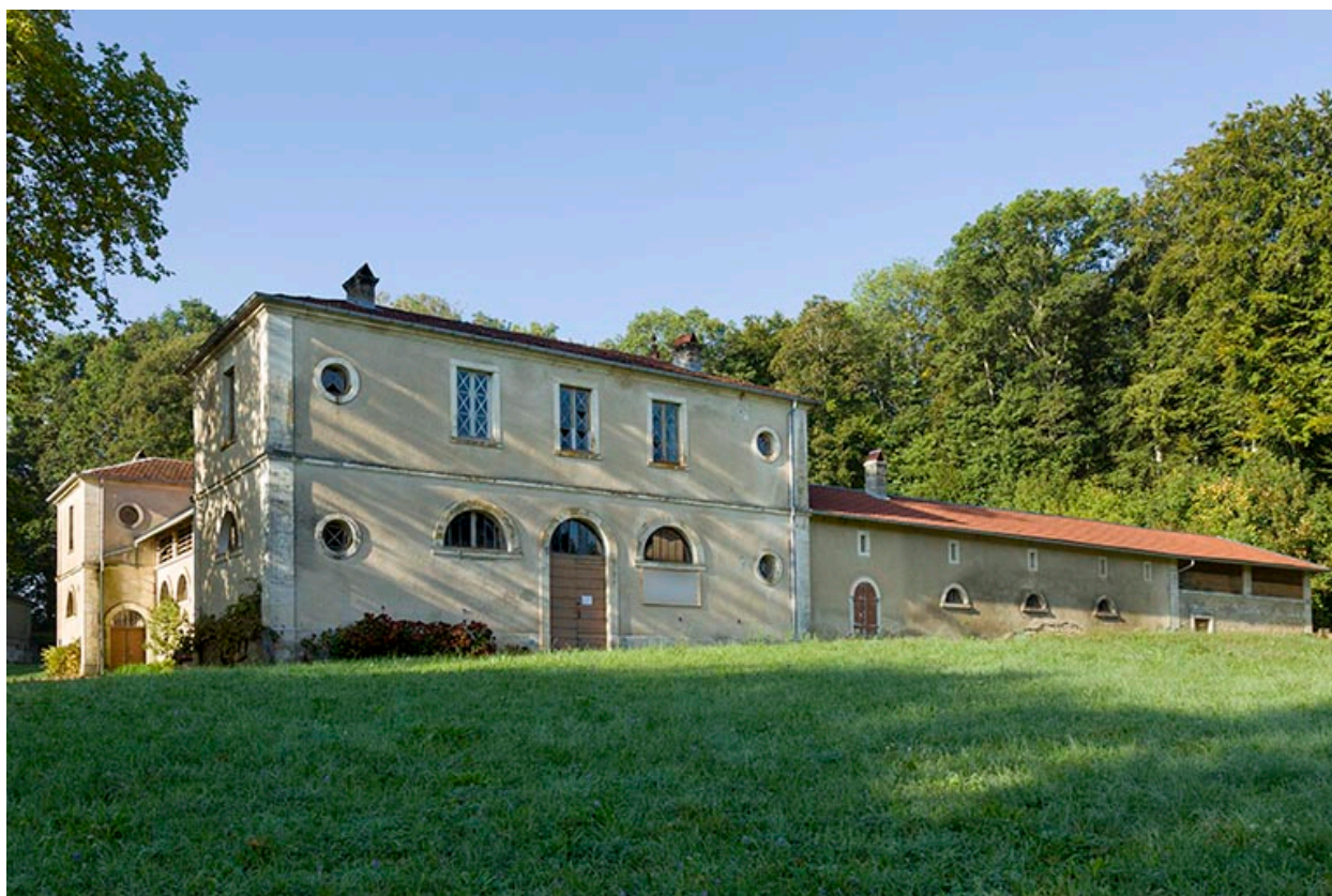
Ecurie : façade nord-est.
