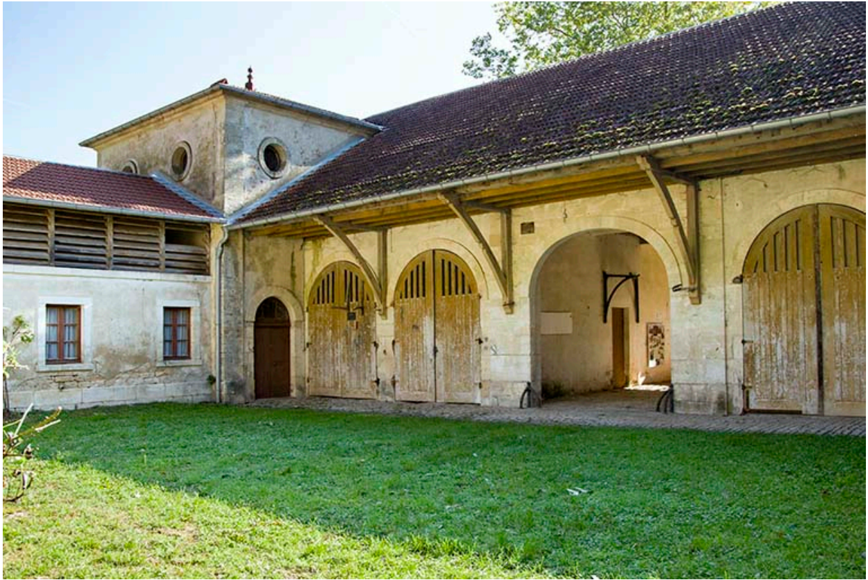
Revers du corps principal depuis la cour : angle est.
