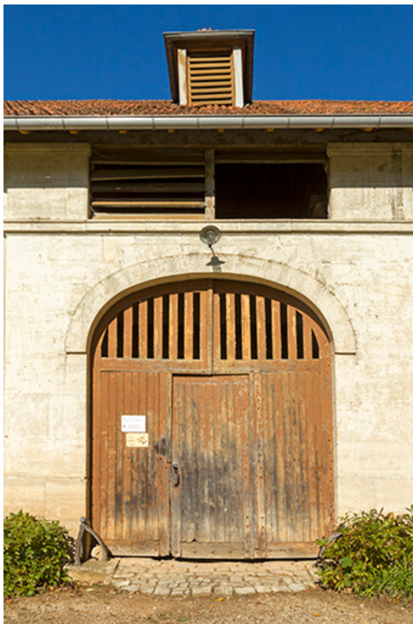
Détail de la façade antérieure au sud-est : la travée du porche.
