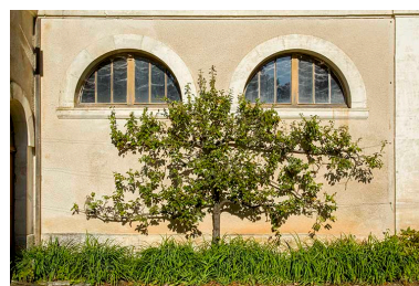
Détail de la façade antérieure au sud-est : deux baies en demi-cercle. Phot. Sonia Dourlot IVR43_20167000762NUC2A
