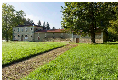
Vue générale des façades nord-est. Phot. Sonia Dourlot IVR43_20167000761NUC2A
