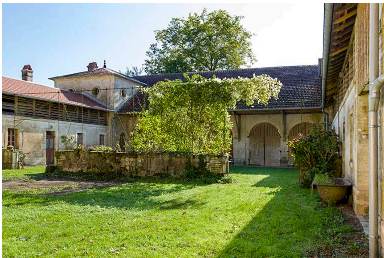
Le corps principal depuis la cour.
