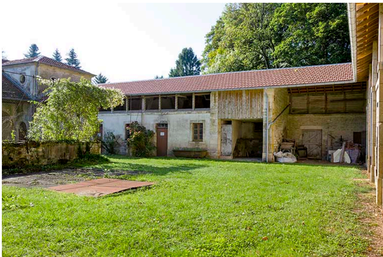
Vue générale de l'aile sud-ouest, côté cour.
