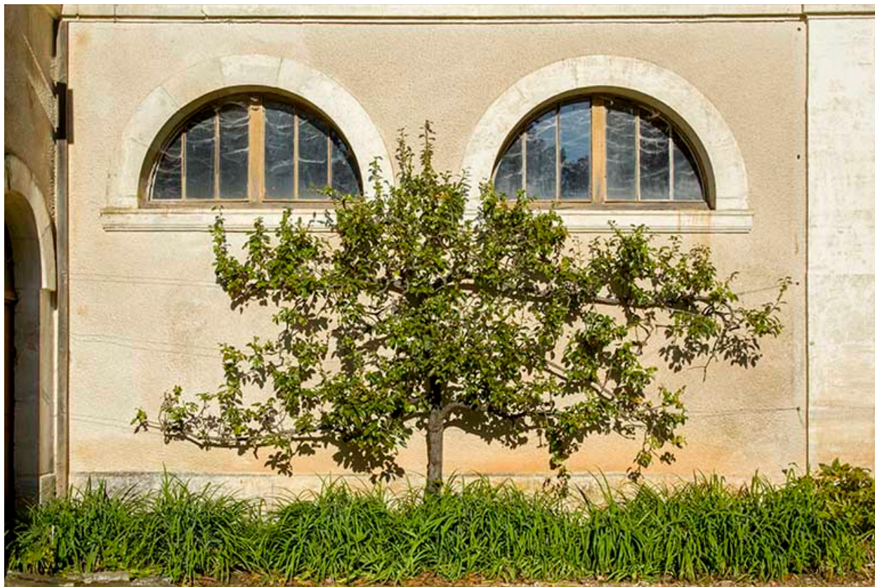
Détail de la façade antérieure au sud-est : deux baies en demi-cercle.
