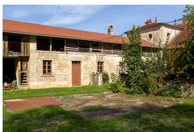
Aile nord-est depuis la cour : ancien logis des fermiers. Phot. Sonia Dourlot IVR43_20167000773NUC2A
