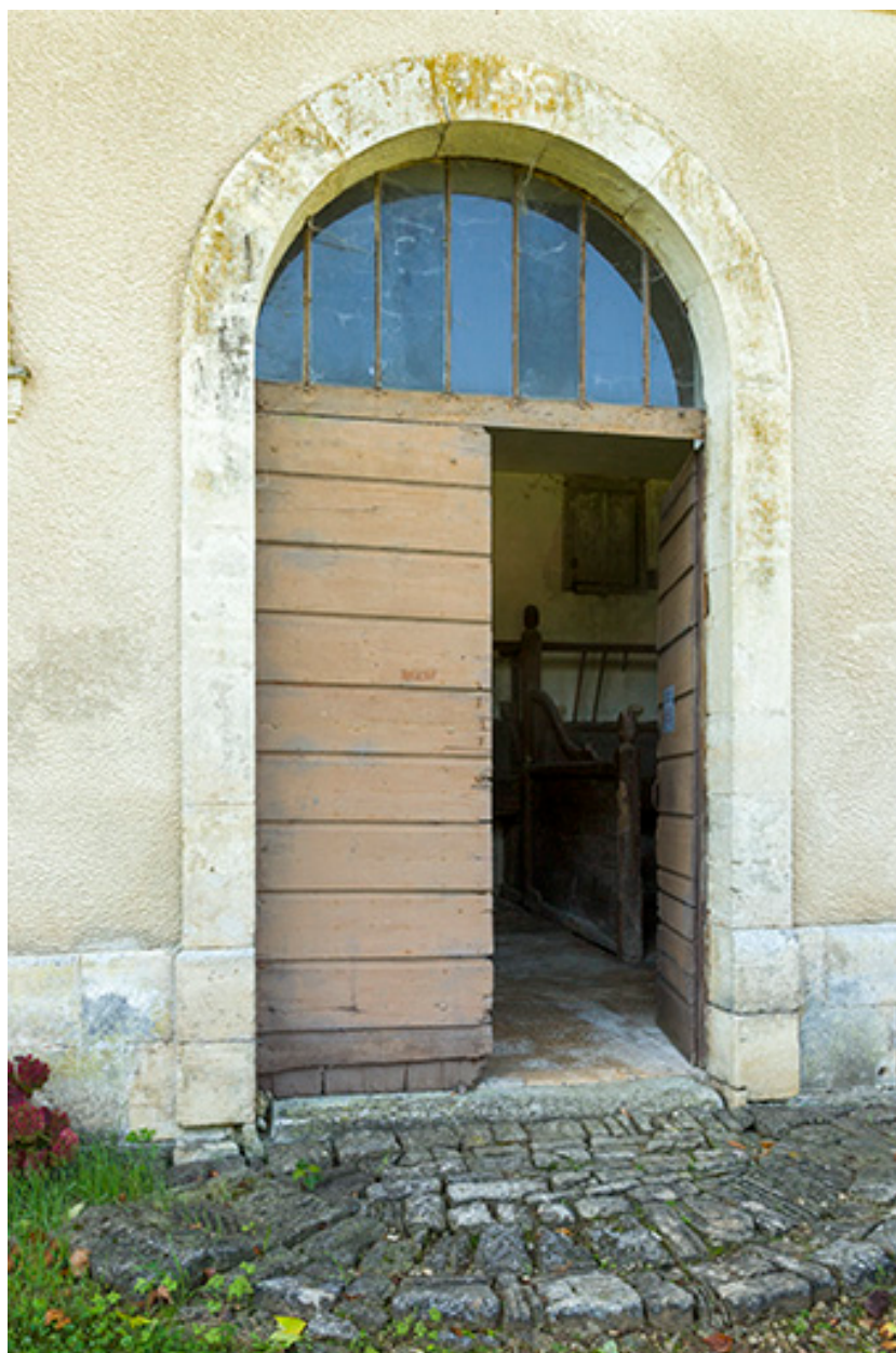
Ecurie, façade nord-est : la porte.
