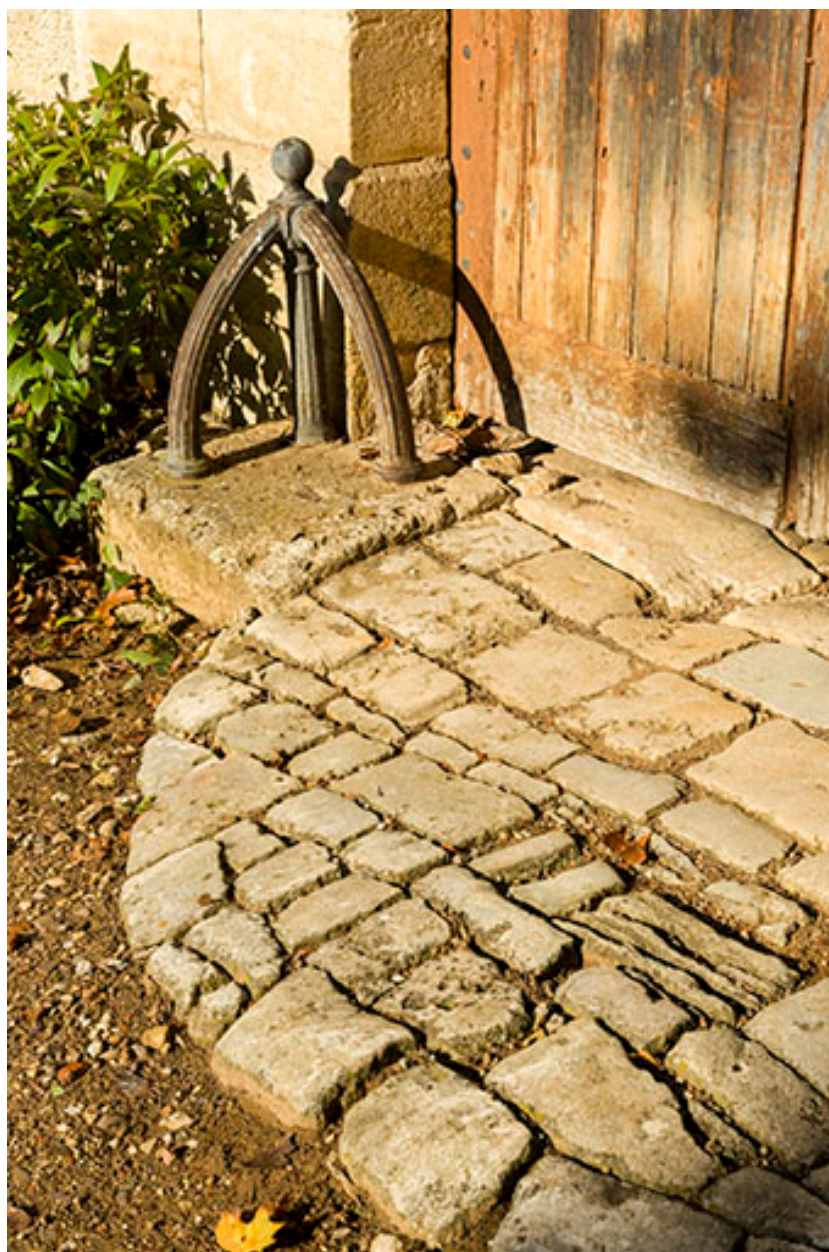
Travée du corps principal : détail du chasse-roue et du pavage.
