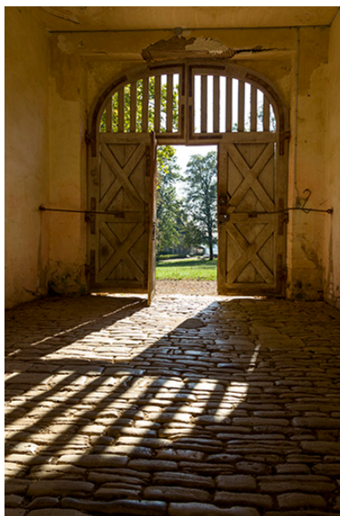
Le porche de la ferme depuis la cour. Phot. Sonia Dourlot IVR43_20167000764NUC2A
