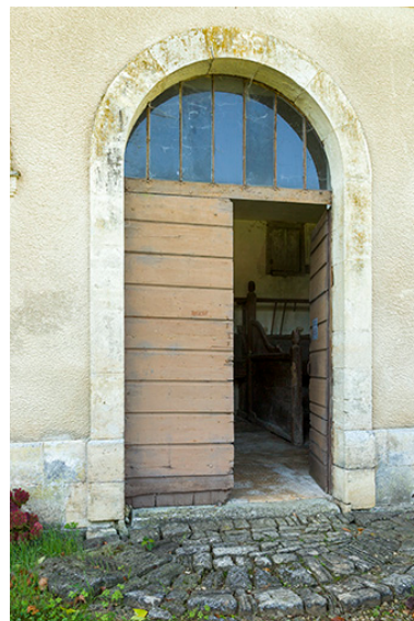
Ecurie, façade nord-est : la porte. Phot. Sonia Dourlot IVR43_20167000779NUC2A
