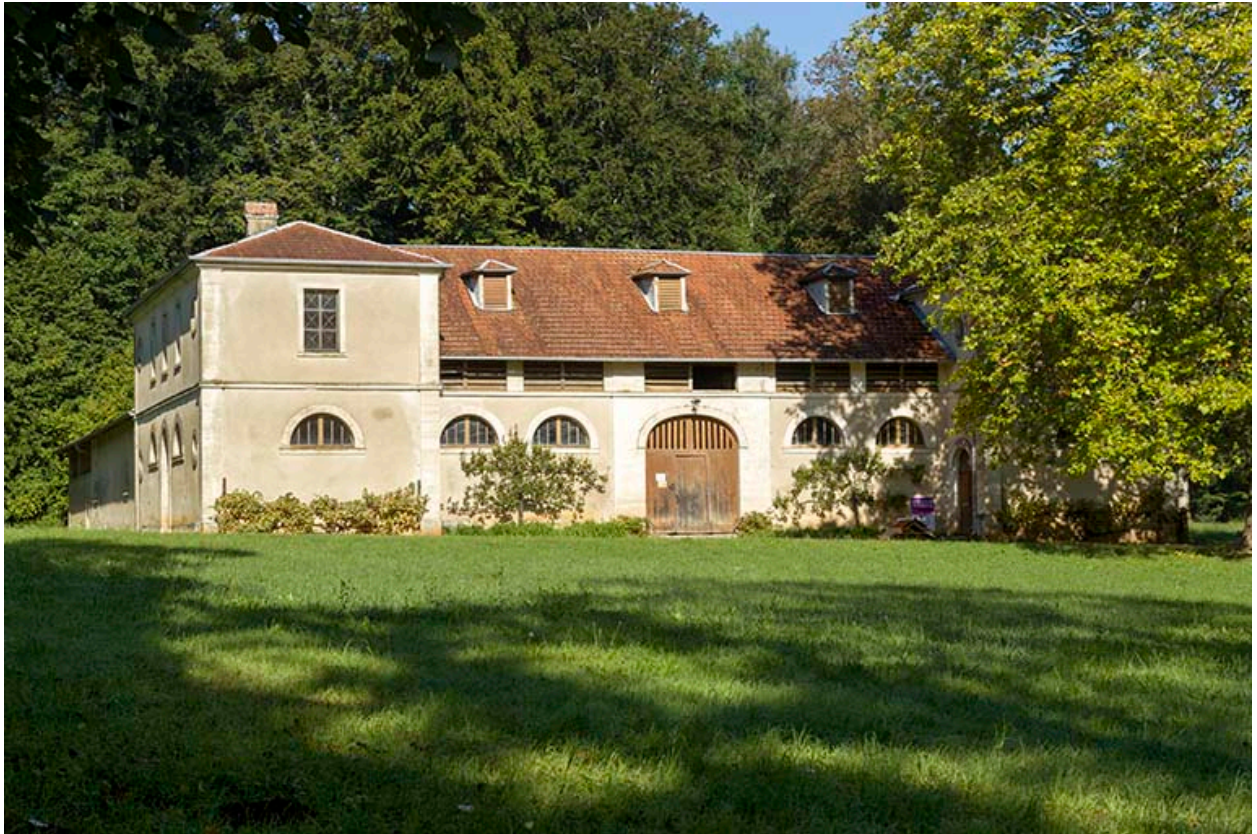
Vue générale de la façade sud-est.
