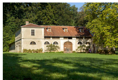
Vue générale de la façade sud-est. Phot. Sonia Dourlot IVR43_20167000758NUC2A
