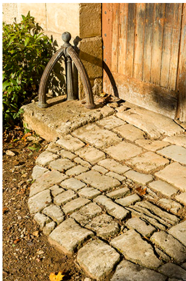
Travée du corps principal : détail du chasse-roue et du pavage. IVR43_20167000766NUC2A
