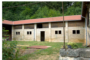
Vue générale de la bergerie, aile nord-ouest. Phot. Sonia Dourlot IVR43_20167000772NUC2A
