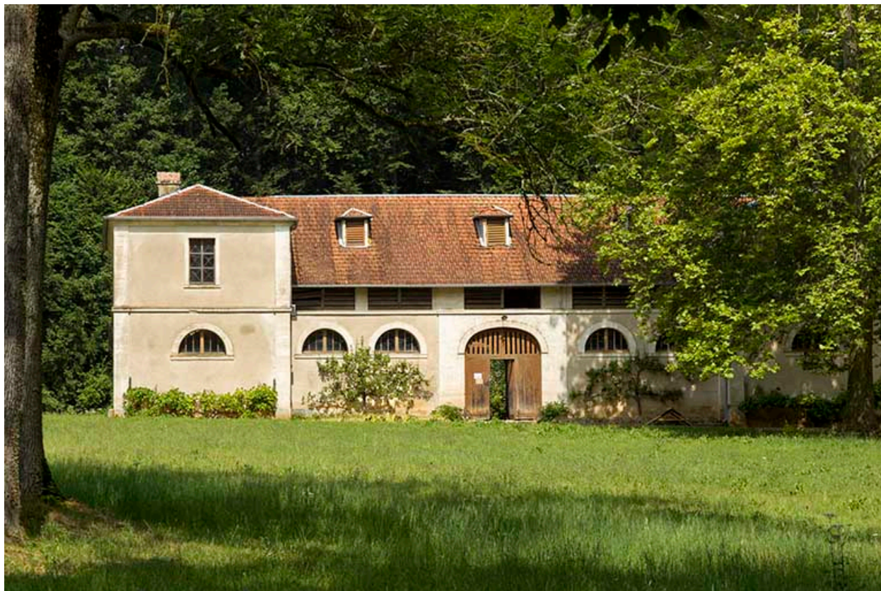
Vue rapprochée de la façade antérieure.
