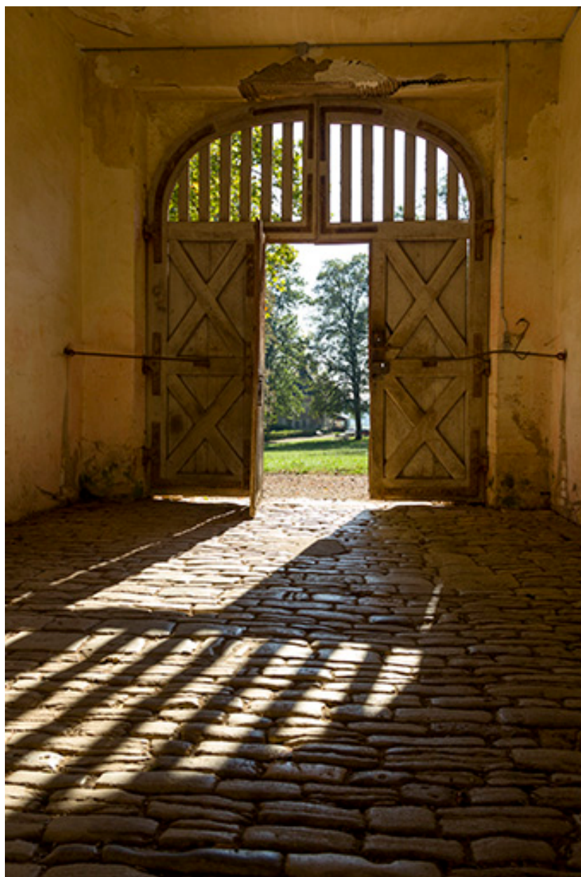
Le porche de la ferme depuis la cour.
