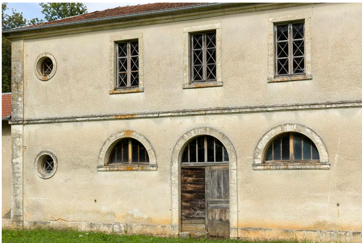
Etable : vue générale de la façade sud-ouest.
