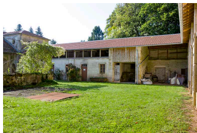
Vue générale de l'aile sud-ouest, côté cour. Phot. Sonia Dourlot IVR43_20167000774NUC2A
