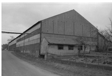
Ancienne chaudronnerie Prudhon acquise par les Ateliers de Constructions Mécaniques Aillot en 1937-39. Phot. Frédéric Pillet IVR26_19997100264Z
