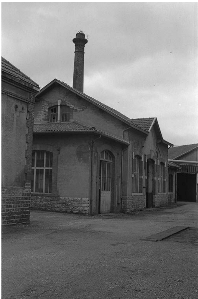
Façade antérieure de l'atelier de montage.
