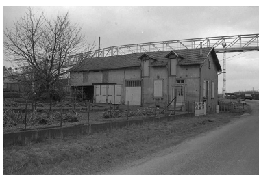
Logement d'ouvriers. Phot. Frédéric Pillet IVR26_19997100263Z
