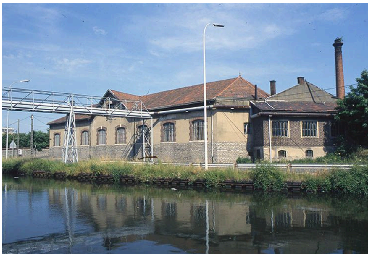
Façade postérieure de l'atelier d'ajustage et de tournage vue depuis les quais.
