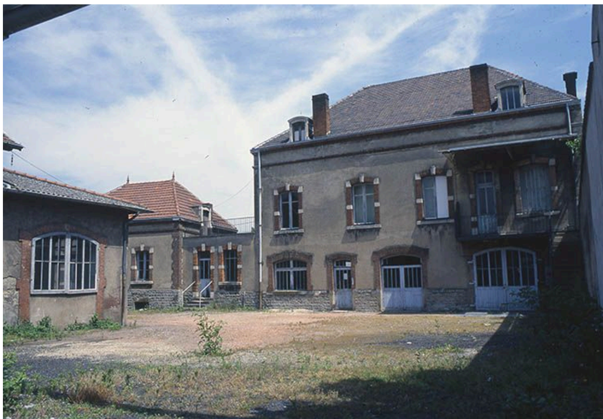
Bureaux (à droite, façade antérieure de l'ancien logement du directeur).
