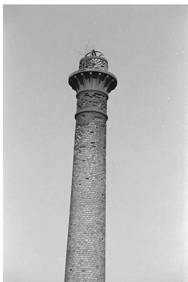
Cheminée des ateliers et son couronnement en fonte. Phot. Frédéric Pillet IVR26_19997100262Z
