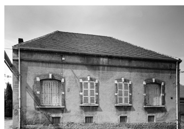
Façade postérieure de l'ancien logement du directeur, transformé en bureau après 1945. Phot. Jean-Luc Duthu IVR26_19967100193V
