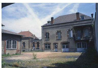
Bureaux (à droite, façade antérieure de l'ancien logement du directeur). Phot. Jean-Luc Duthu IVR26_19967100204ZA
