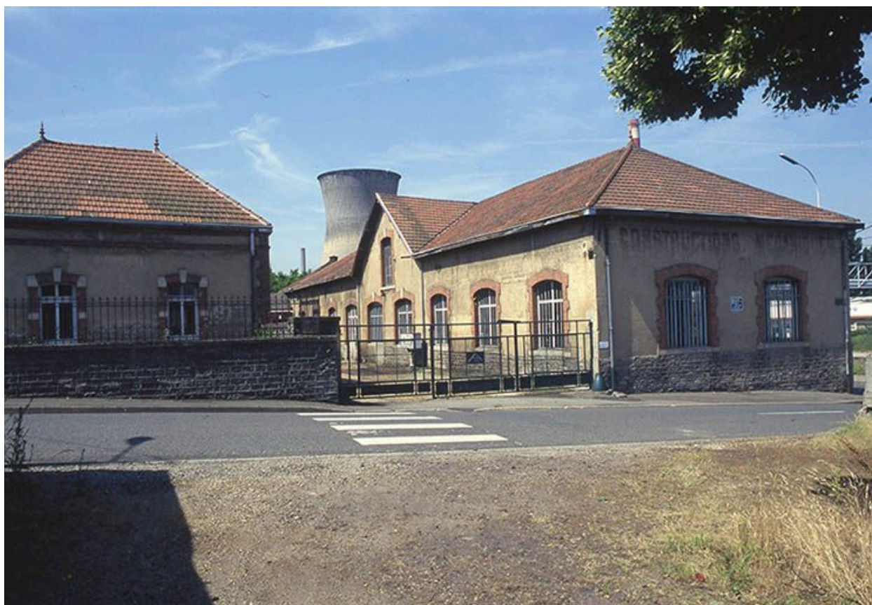
Façade postérieure de l'ancien logement du directeur, transformé en bureau après 1945.
