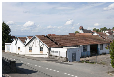
Ateliers de fabrication nord. Phot. Jérôme Mongreville IVR43_20112501235NUC4A
