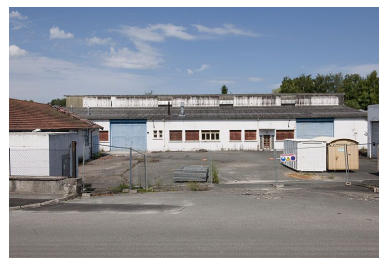
Vue de l'entrée. Phot. Jérôme Mongreville IVR43_20112501236NUC4A
