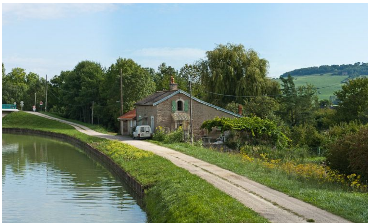
Vue de la maison de garde.
