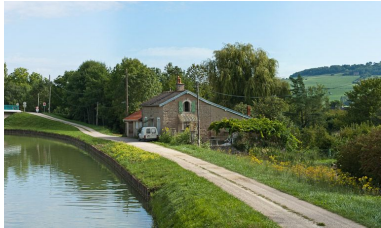
Vue de la maison de garde. Phot. Pierre-Marie Barbe-Richaud IVR26_20112103935NUC4AQ
