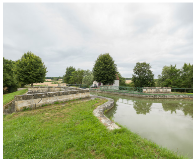
Vue du site. Phot. Pierre-Marie Barbe-Richaud IVR26_20175800223NUC2AQ
