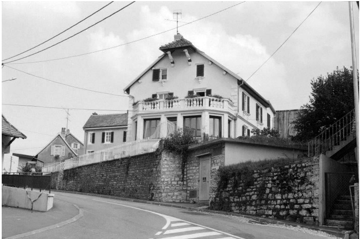
Façades latérale droite et postérieure.
