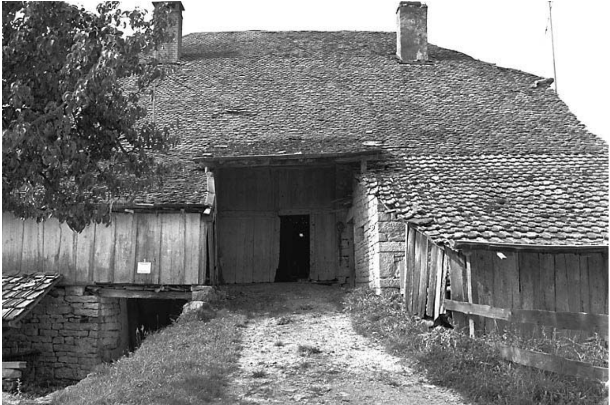
Face latérale droite : entrée de grange.
