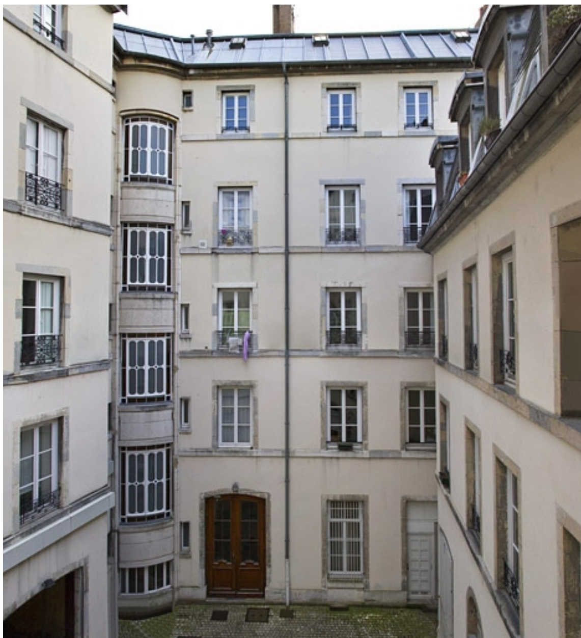
Logis principal, façade postérieure, côté rue Morand.
