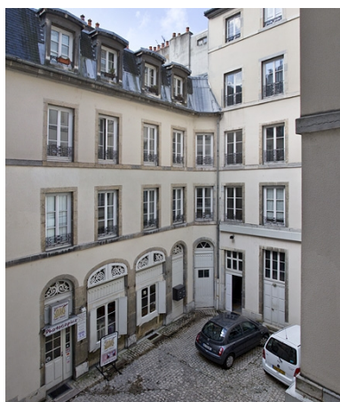
Logis secondaire : de trois quarts gauche. Phot. Yves Sancey IVR43_20122500528NUC2A
