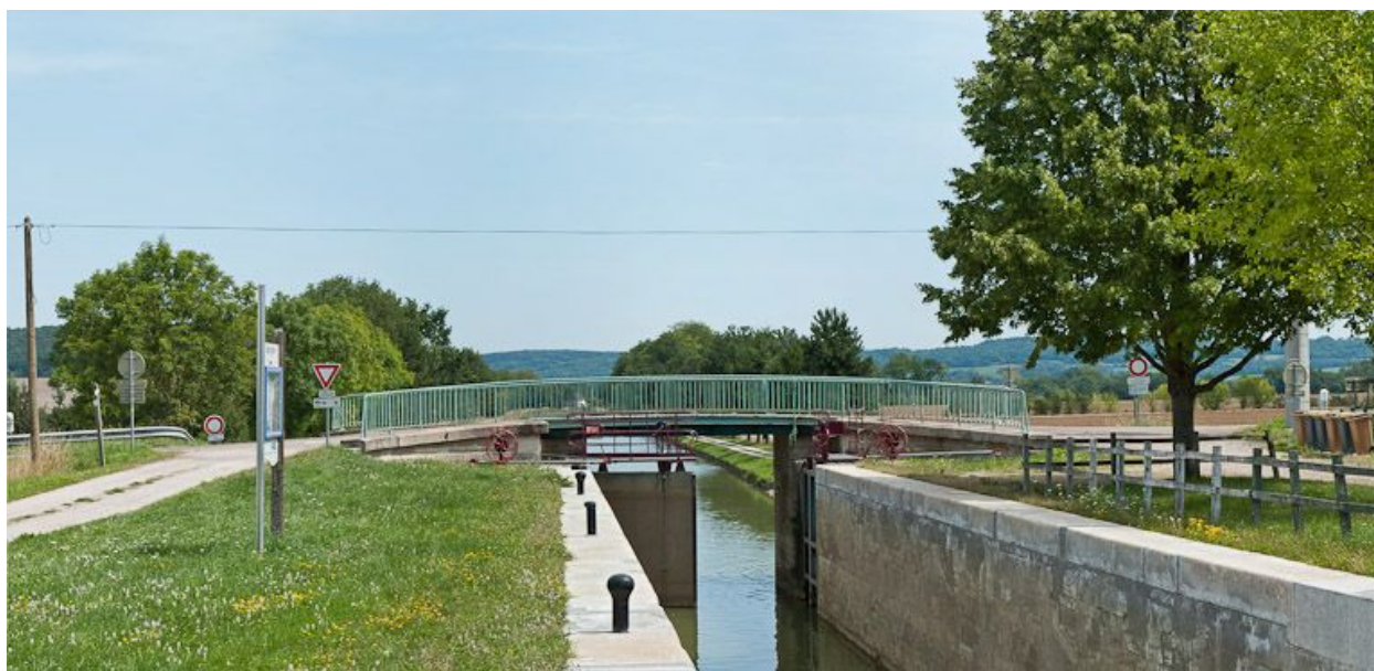
Vue du pont depuis l'amont.
