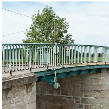
Détail du garde-corps avec la poulie.
