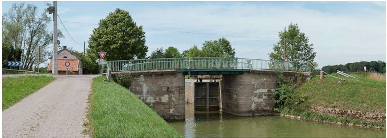
Vue du pont depuis l'aval.
