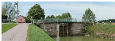
Vue du pont depuis l'aval.
