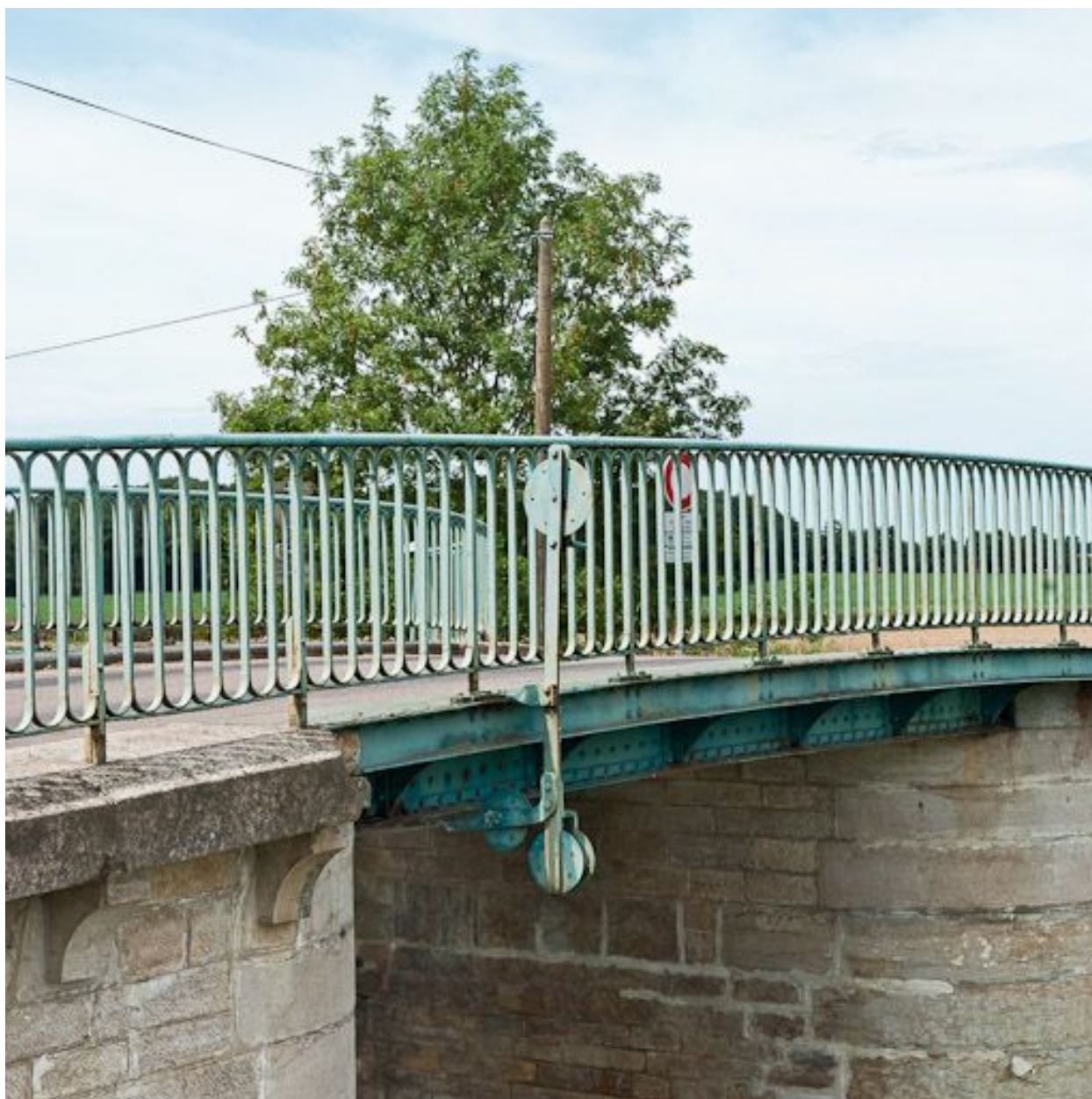
Détail du garde-corps avec la poulie.
