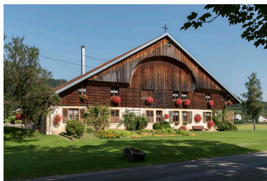
Ferme : façade antérieure, de trois quarts gauche.
