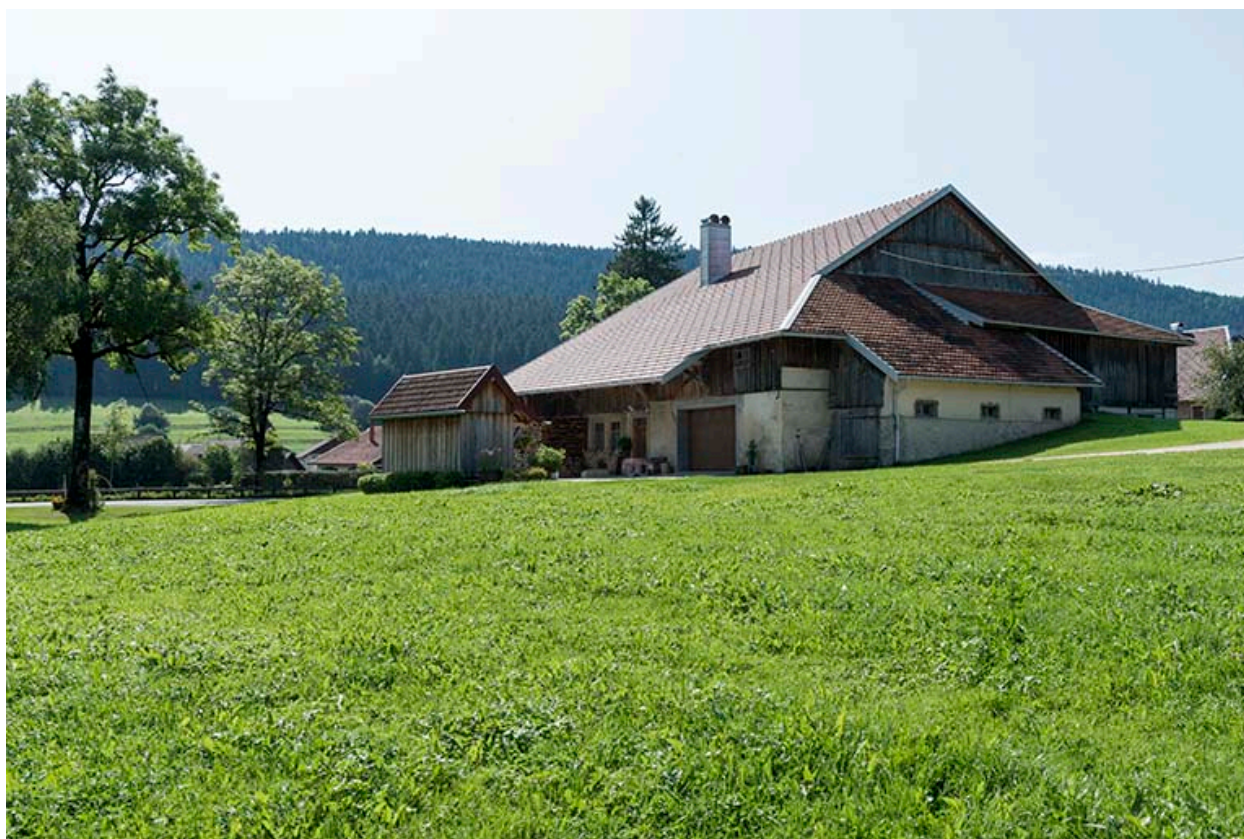
Ferme : façades postérieure et latérale droite.
