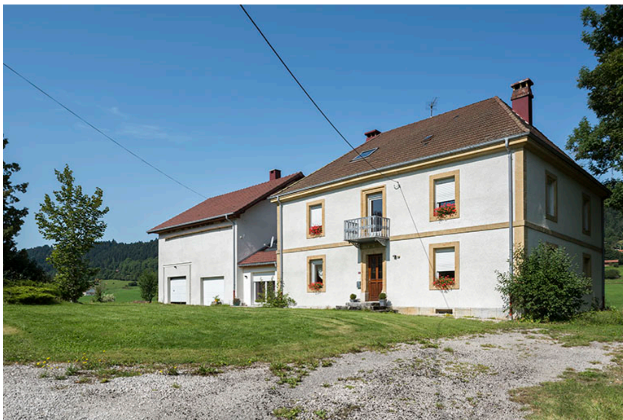
Maison et garage, de trois quarts droite.
