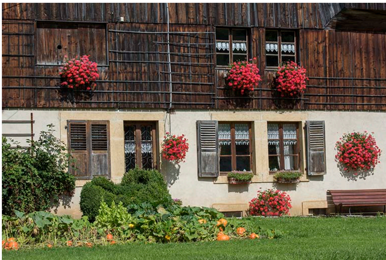
Ferme, façade antérieure : baies.
