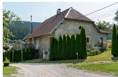
Taillanderie : façades antérieure et latérale droite. Phot. Sonia Dourlot IVR43_20172501225NUC4A
