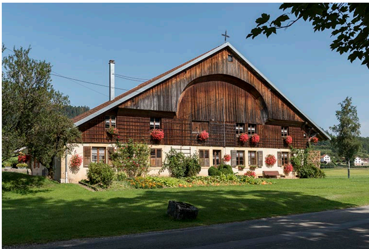
Ferme : façade antérieure, de trois quarts gauche.
