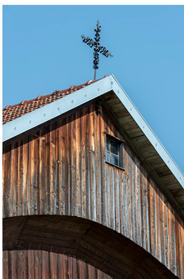
Ferme, façade antérieure : croix de faîtage. Phot. Sonia Dourlot IVR43_20172501210NUC4A
