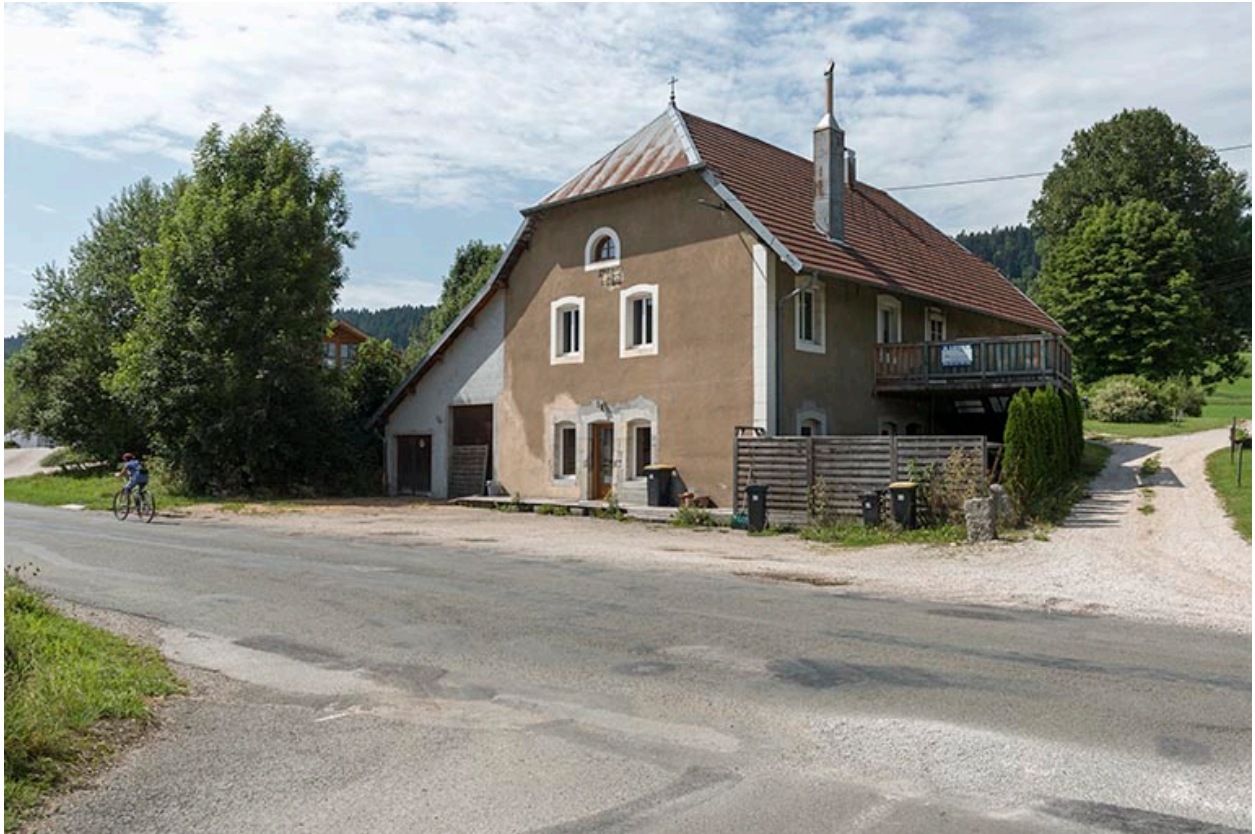
Taillanderie : façades antérieure et latérale gauche. L'arbre à gauche marque l'emplacement de la scierie détruite.
