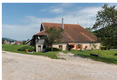
Ferme : façade latérale gauche. Phot. Sonia Dourlot IVR43_20172501205NUC4A
