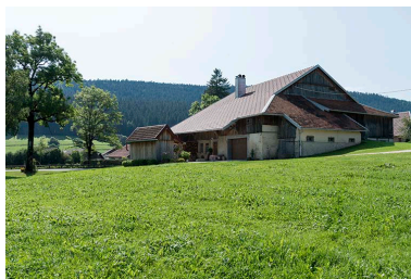
Ferme : façades postérieure et latérale droite.
