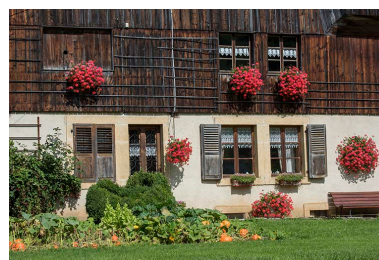
Ferme, façade antérieure : baies. Phot. Sonia Dourlot IVR43_20172501207NUC4A
