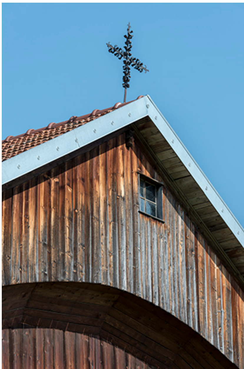
Ferme, façade antérieure : croix de faîtage.
