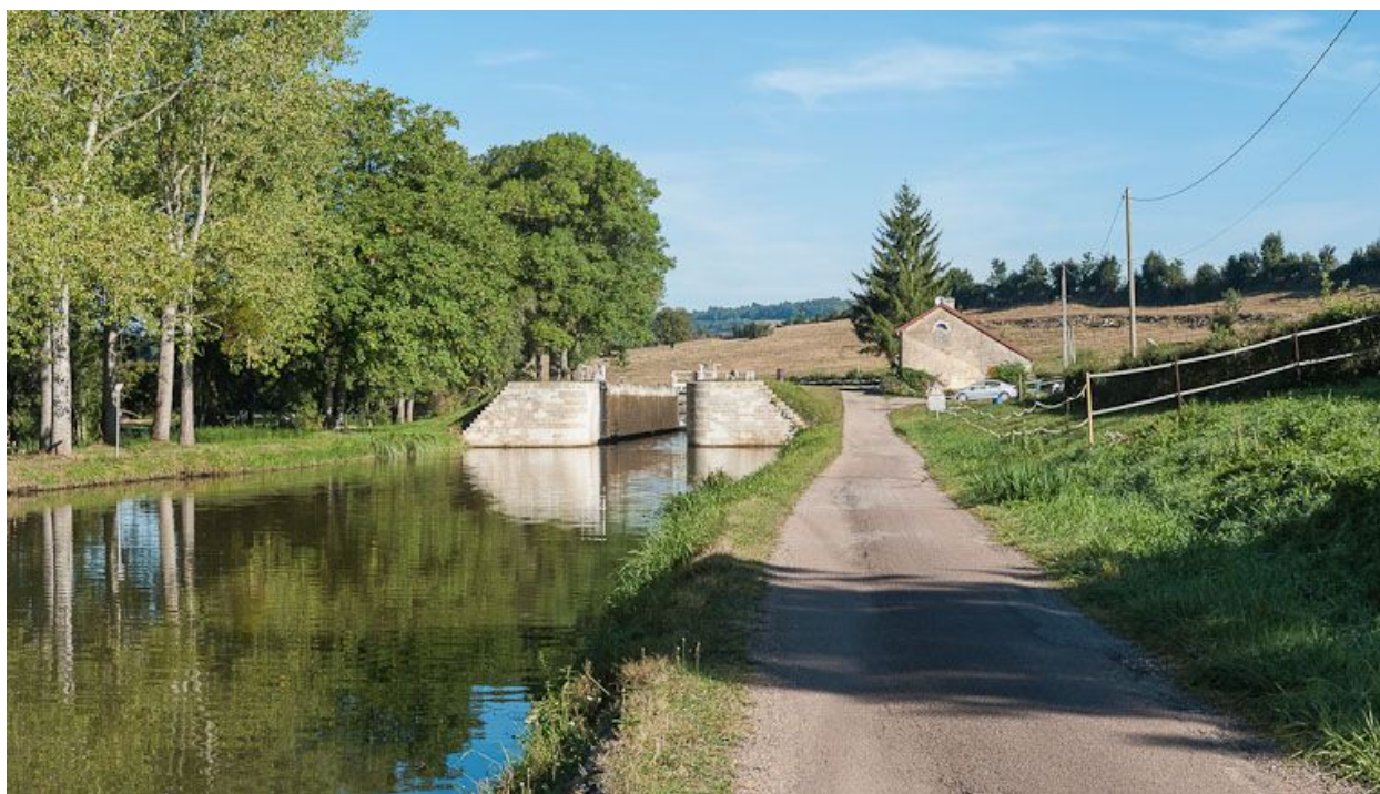
Vue du sas d'écluse depuis l'aval.
