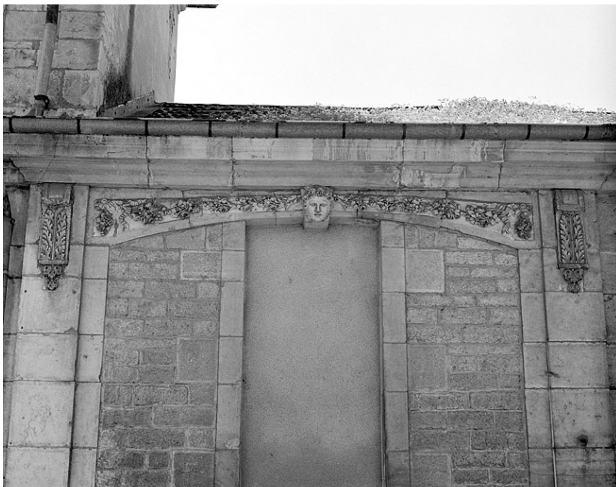
Détail du mur d'enclos côté Grande Rue.
