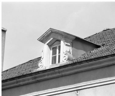
Détail d'une lucarne.
