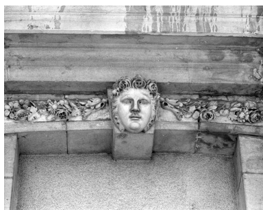
Détail : décor du mur d'enclos.
