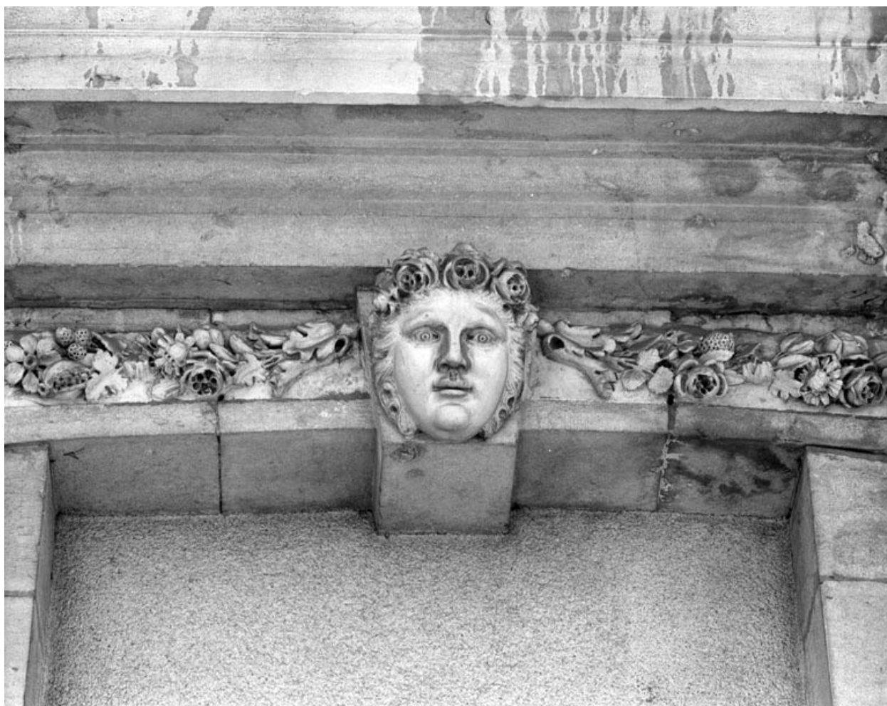
Détail : décor du mur d'enclos.
