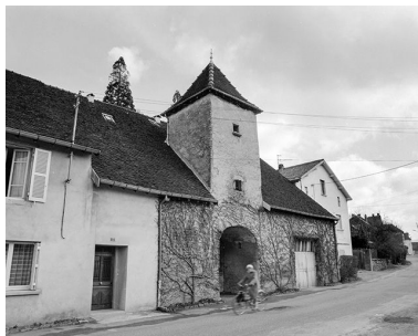
Façade antérieure, vue de trois quarts. Phot. Jérôme Mongreville IVR43_19853900116X
