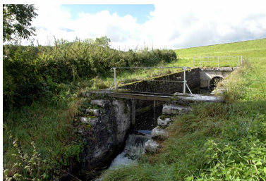
Aqueduc de vidange au centre de la digue principale. Phot. Alain Morelière IVR26_20072106115NUC2A
