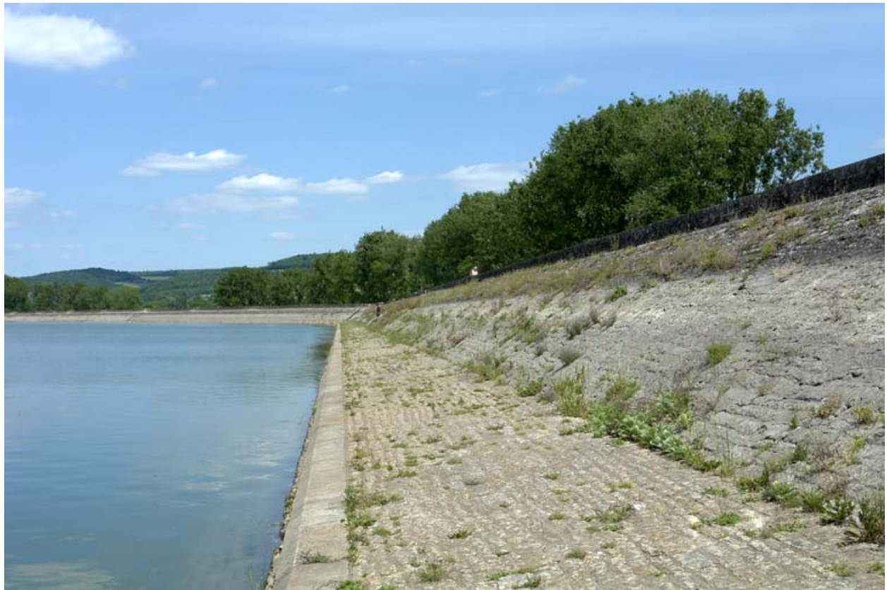
Digue est, vue d'ensemble.
