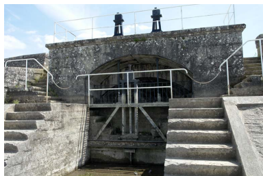
Digue est, ouvrage avec vannes en sortie du réservoir. Phot. Alain Morelière IVR26_20072106113NUC2A
