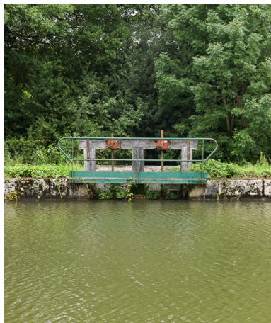
Vue du déversoir de fond. Phot. Pierre-Marie Barbe-Richaud IVR26_20175800300NUC2A
