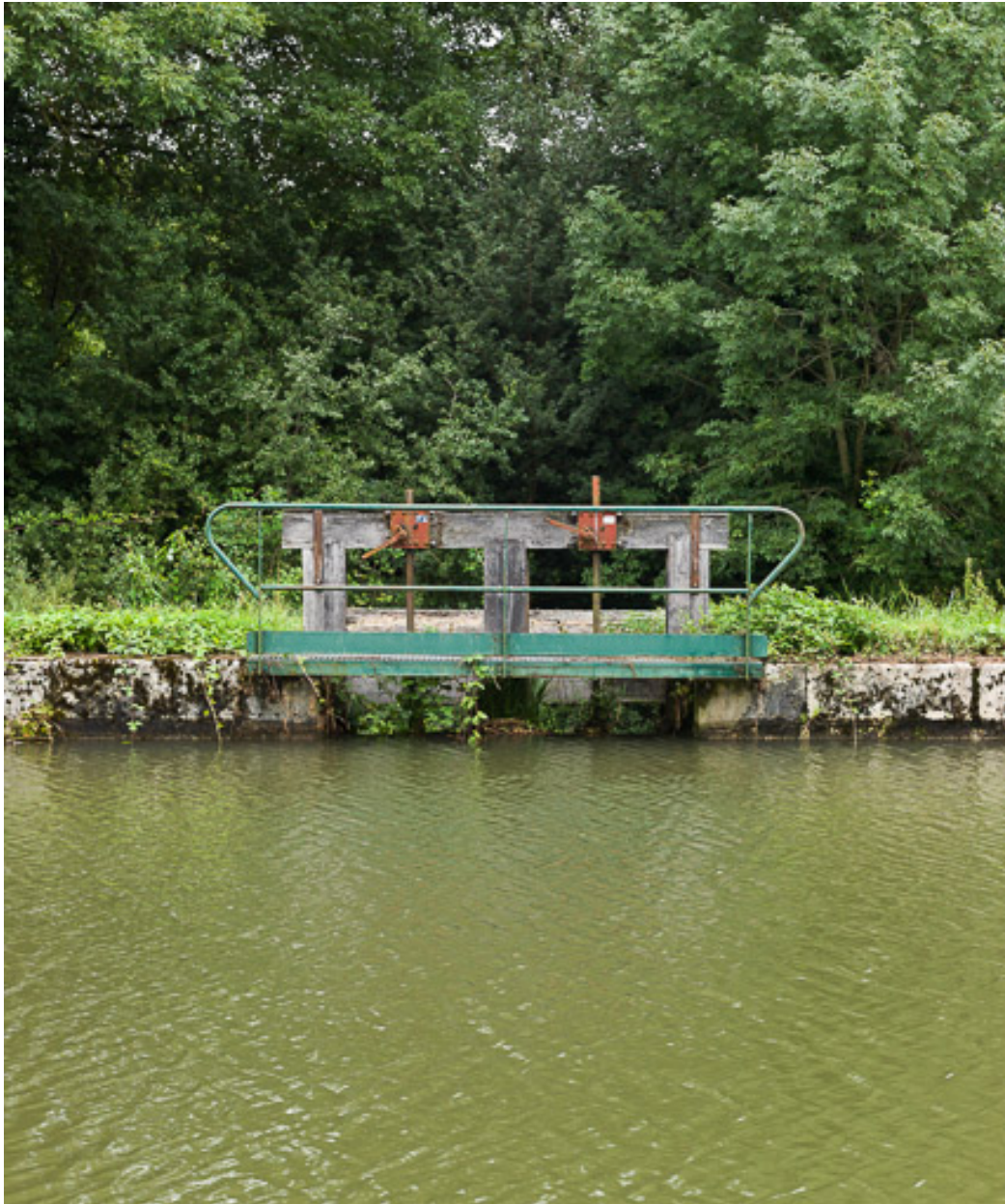
Vue du déversoir de fond.
