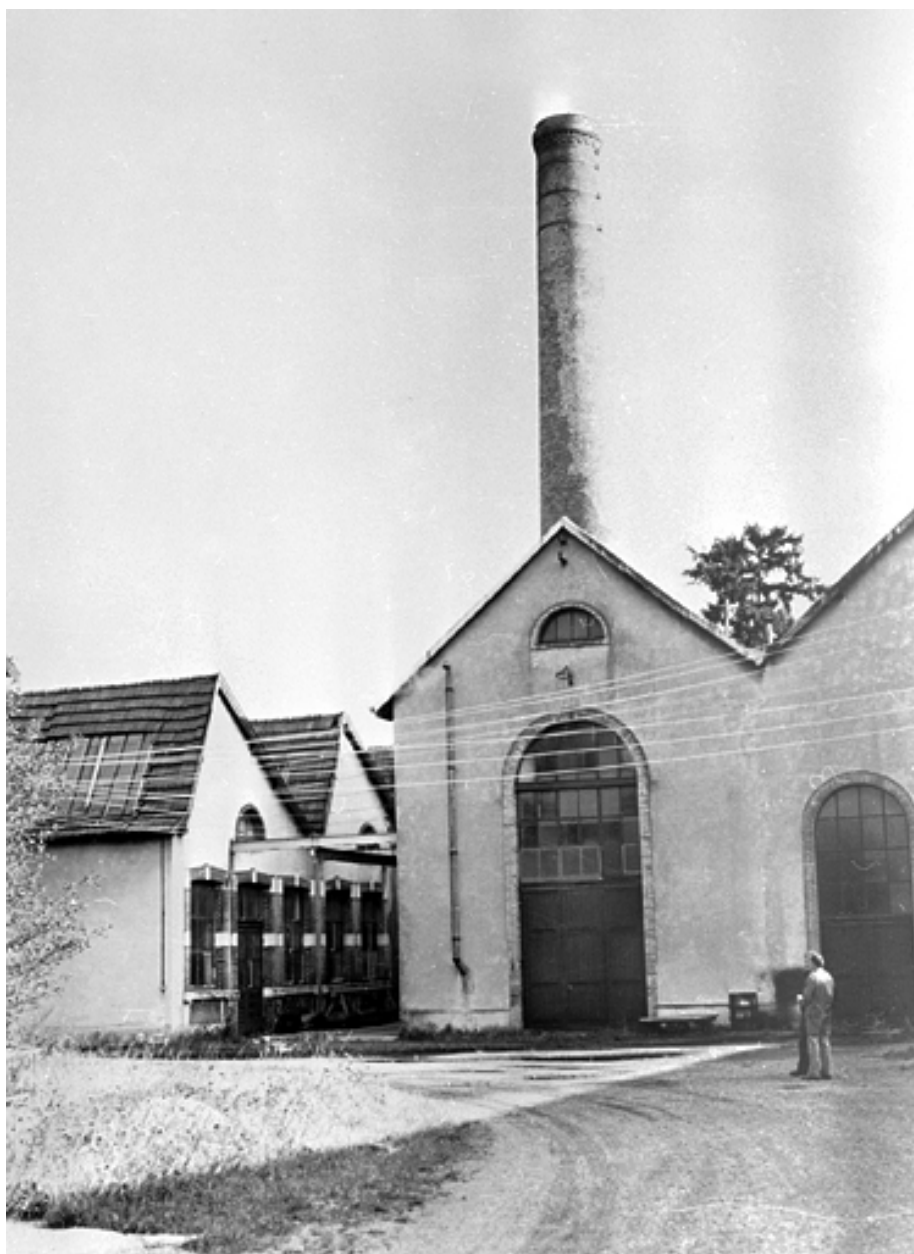
Salle des machines et sa cheminée.
