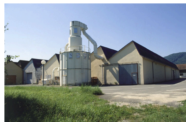
Extrémité nord des ateliers de fabrication. Phot. Yves Sancey IVR43_20009000237ZA
