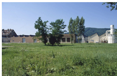
Pignons des ateliers depuis l'est. Phot. Yves Sancey IVR43_20009000239ZA
