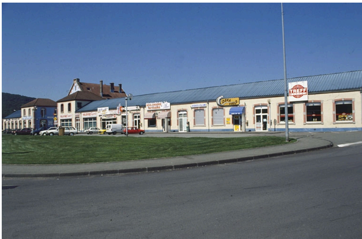
Vue rapprochée depuis le sud-est.
