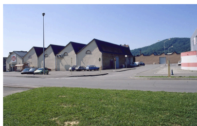
Pignons est d'ateliers (?) couverts de sheds. Phot. Yves Sancey IVR43_20009000243ZA
