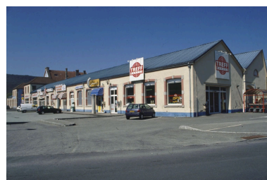
Façades sud vues de trois quarts. Phot. Yves Sancey IVR43_20009000226ZA
