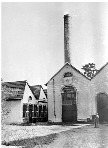
Salle des machines et sa cheminée. Phot. Jérôme Mongreville IVR43_20019000110X
