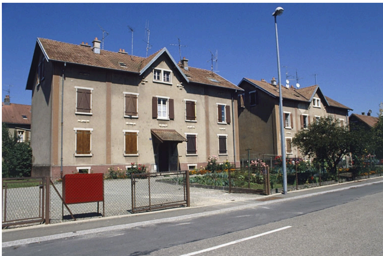
Logements collectifs ouvriers rue Georges Dollfus.
