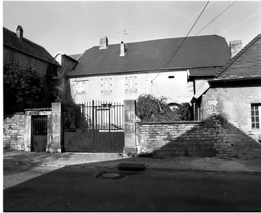
Edifice sur cour fermée. Phot. Dominique Dominguez IVR43_19807000340X
