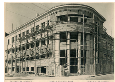
Construction de l'usine Brochet Frères, s.d. [1946 ?]. IVR43_20192500059NUC4A
