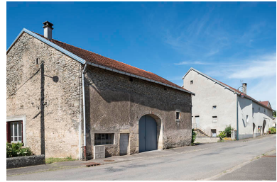
Ferme. Phot. Jérôme Mongreville IVR43_20177000742NUC4A
