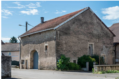
Ferme. Phot. Jérôme Mongreville IVR43_20177000741NUC4A
