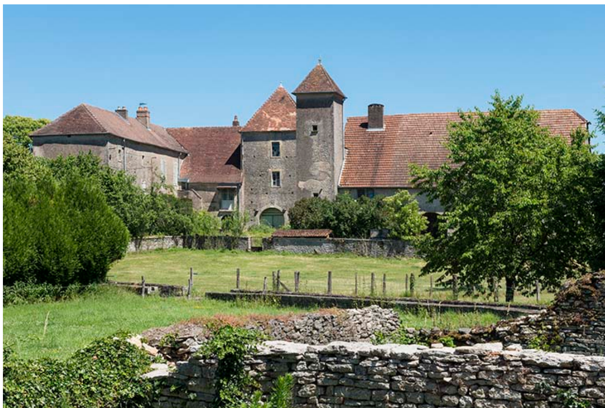
Vue générale de la maison forte.
