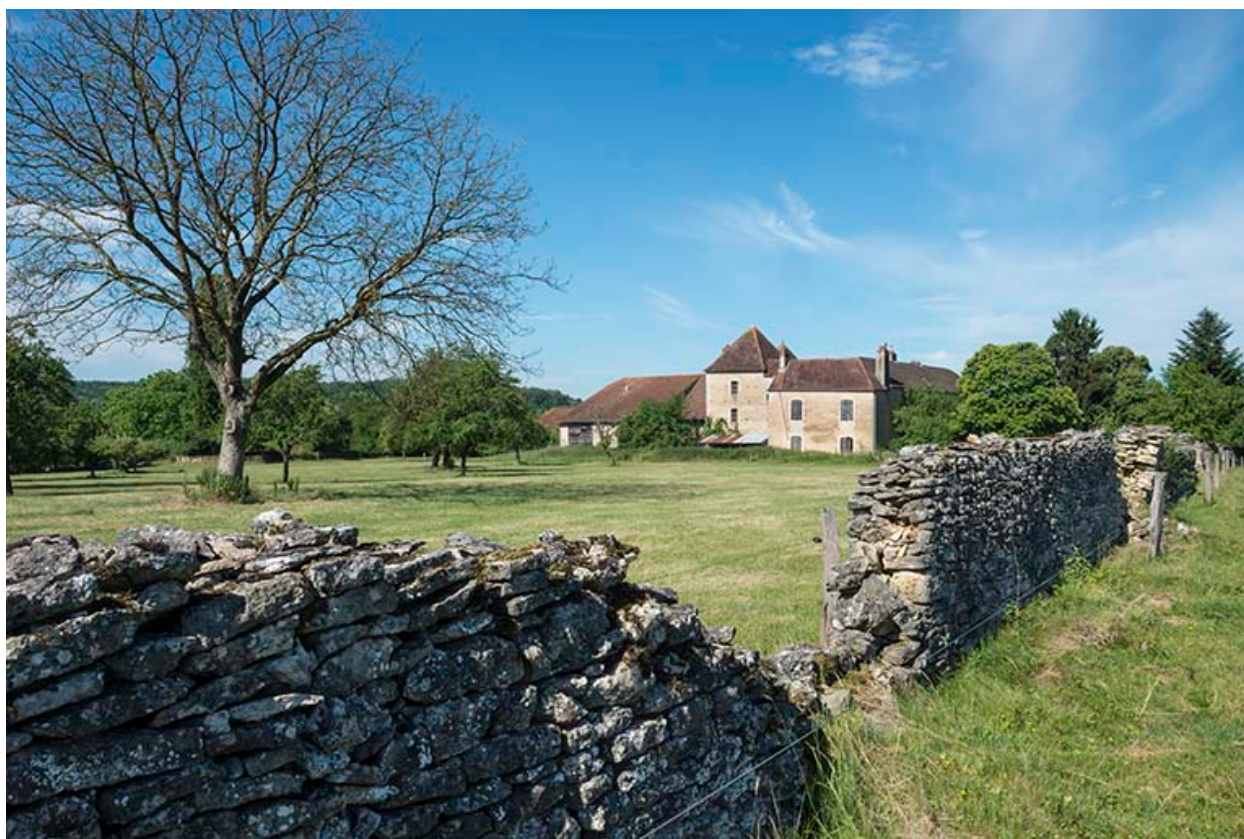
La façade orientale de la maison forte.
