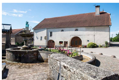
Façade principale de la ferme située au n°2 route de Scey-sur-Saône, vue depuis la fontaine. Phot. Jérôme Mongreville IVR43_20177000738NUC4A
