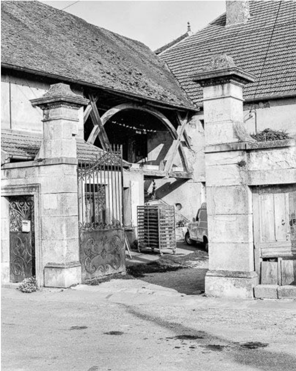
Détail de la partie habitation.
