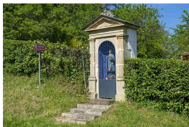
Oratoire saint Vincent. Phot. Jérôme Mongreville IVR43_20217000314NUC4A
