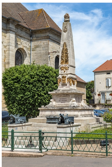
Monument aux morts vu de trois-quart droit. Phot. Jérôme Mongreville IVR43_20217000375NUC4A
