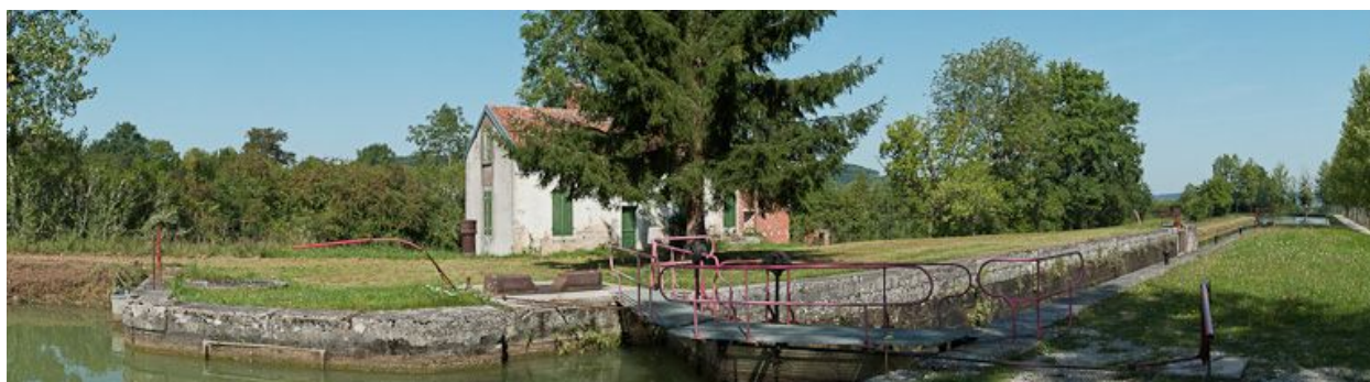
Vue d'ensemble du site d'écluse.
