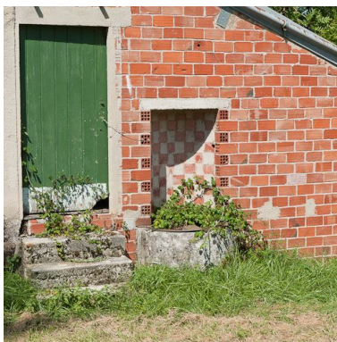
Détail de l'annexe latérale. Phot. Pierre-Marie Barbe-Richaud IVR26_20112103908NUC2AQ
