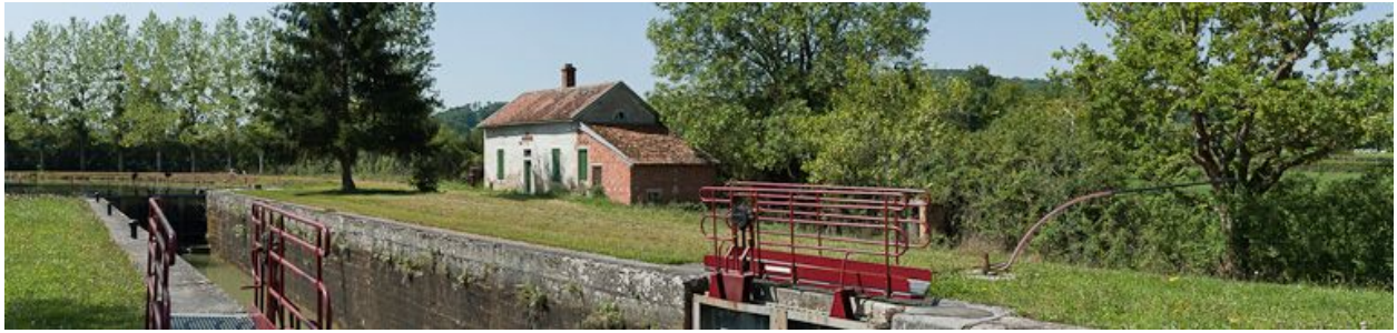
Vue d'ensemble du site d'écluse.
