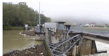
Vannage sur le barrage . Vanne clapet de surface au premier plan.
