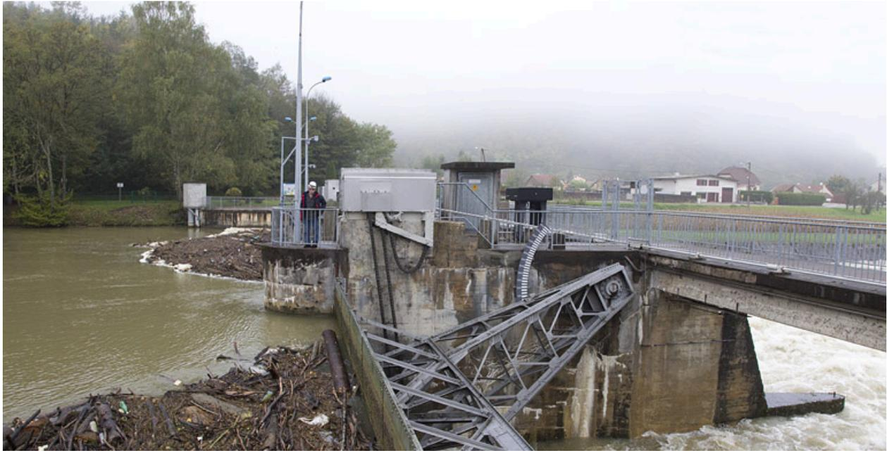
Vannage sur le barrage . Vanne clapet de surface au premier plan.
