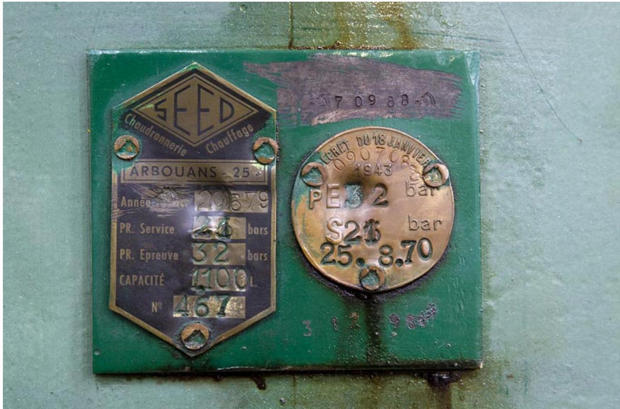
Réservoir d'air comprimé. Plaque d'épreuve.
