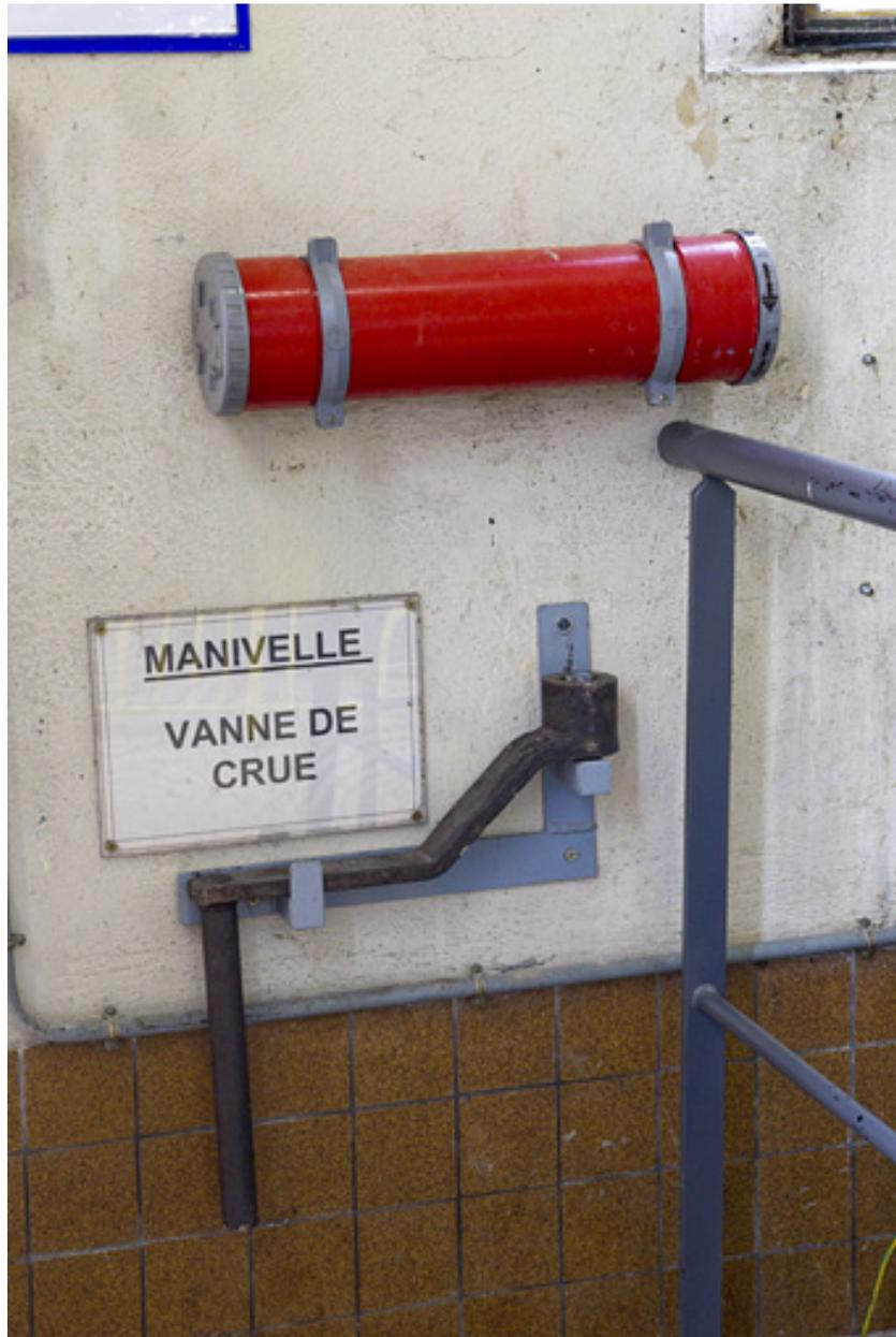
Manivelle de secours (commande du vannage).
