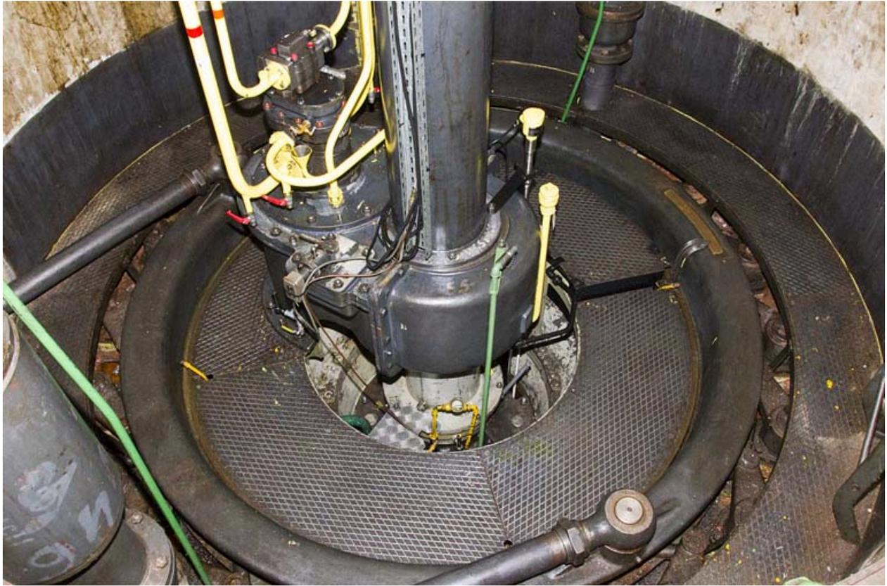
Partie supérieure d'une turbine et axe de transmission vertical.
