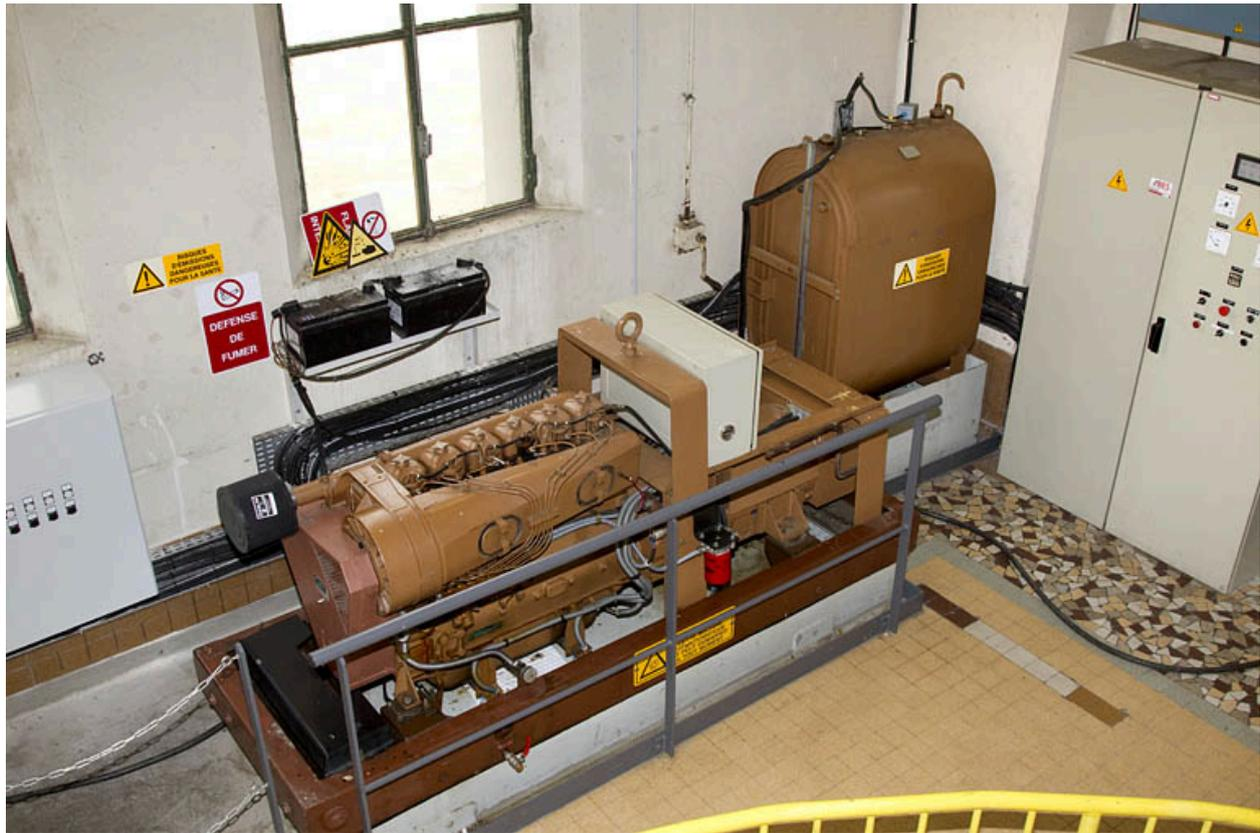
Groupe électrogène de secours (commande du vannage).
