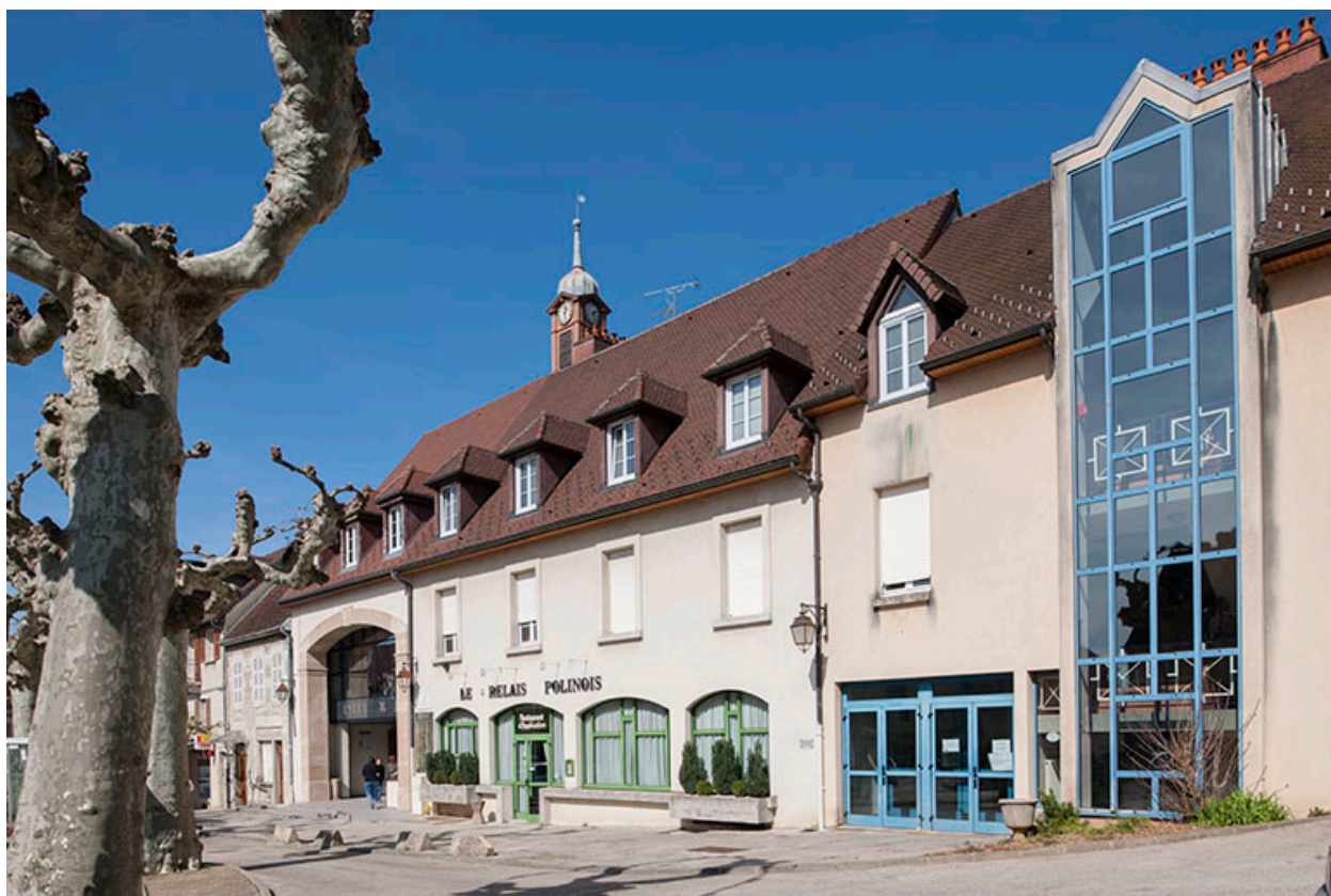
Restaurant d'application: façade antérieure, place des déportés.
