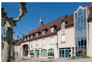
Restaurant d'application: façade antérieure, place des déportés.
