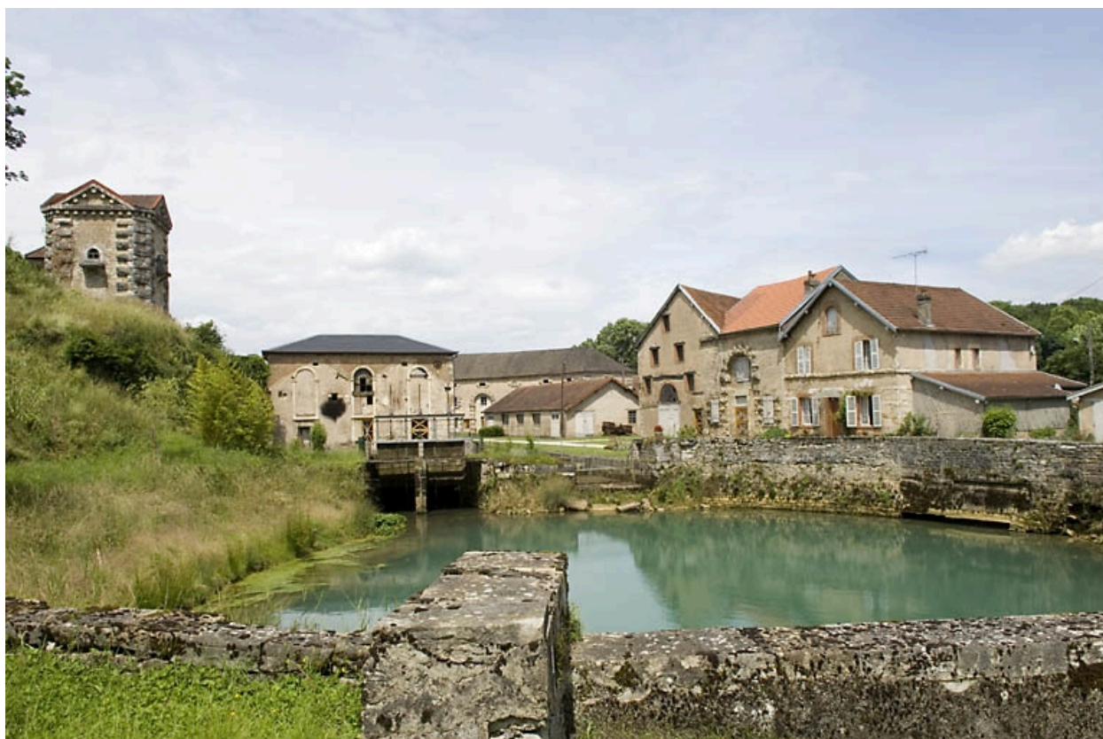
Forges de Baignes : vue d'ensemble depuis le sud-est.
