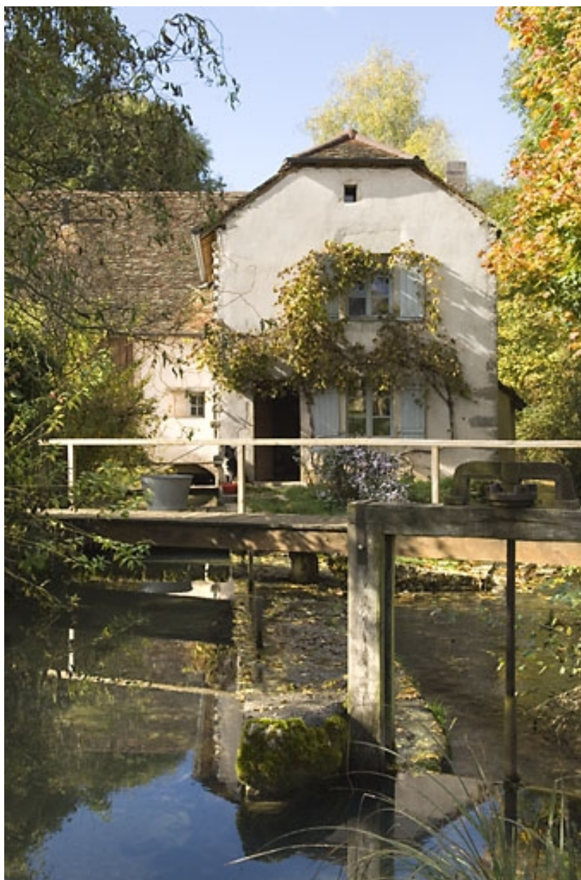
Moulin de Fondremand : vue d'ensemble depuis l'est, avec le bief d'aménée.
