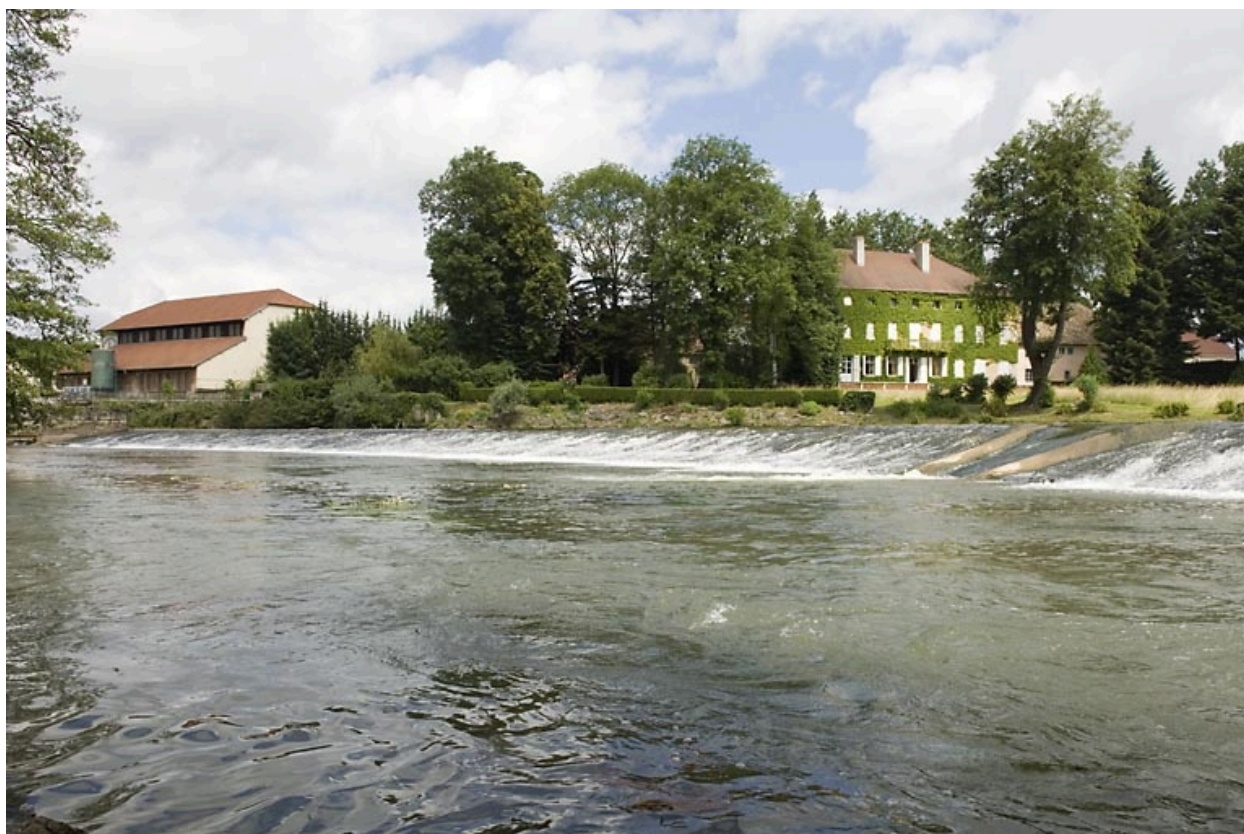
Larians-et-Munans, fonderie de la Société des Fonderies de Treveray : vue d'ensemble depuis la rive gauche de l'Ognon.
