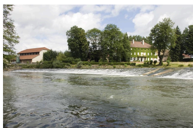
Larians-et-Munans, fonderie de la Société des Fonderies de Treveray : vue d'ensemble depuis la rive gauche de l'Ognon. Phot. Jérôme Mongreville IVR43_20087000727NUC2A
