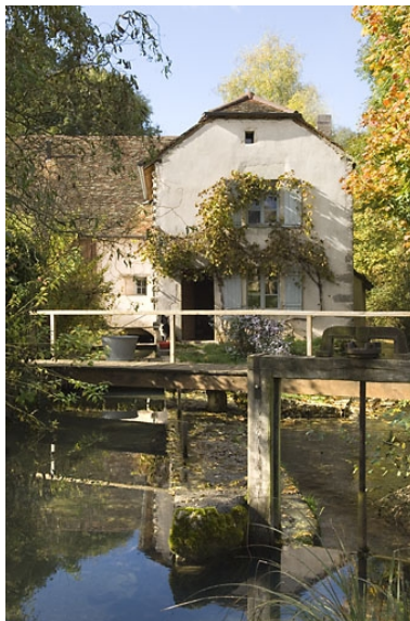
Moulin de Fondremand : vue d'ensemble depuis l'est, avec le bief d'aménée. Phot. Jérôme Mongreville IVR43_20087000969NUC2A
