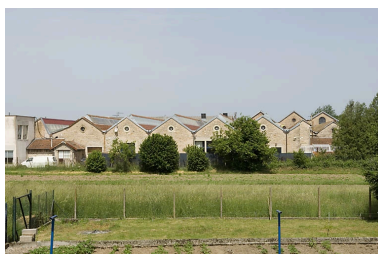
Fonderie de Saint-Sauveur et ateliers municipaux : vue d'ensemble depuis le sud-est. Phot. Jérôme Mongreville IVR43_20077000270NUCA
