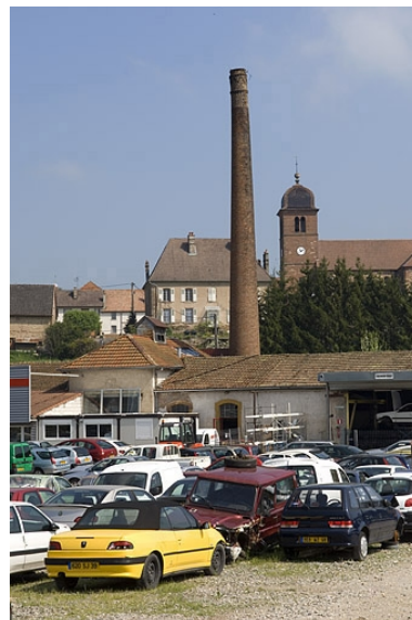
La chaufferie et la cheminée. Phot. Jérôme Mongreville IVR43_20067000240NUCA
