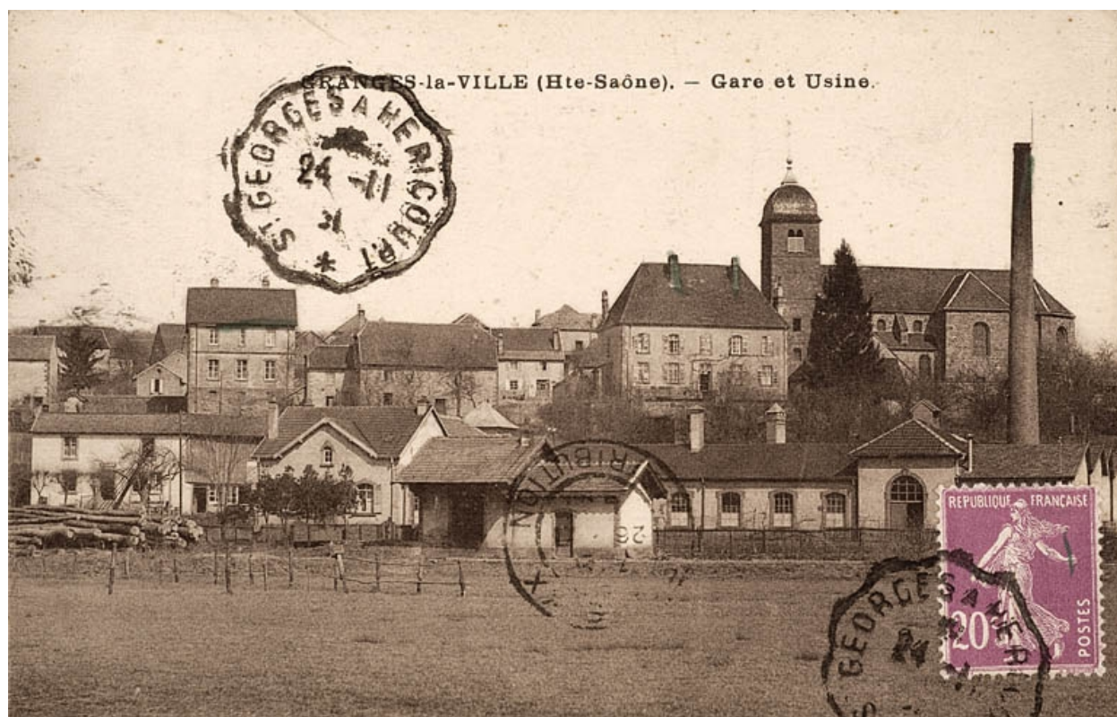
Granges-la-ville (Haute-Saône) - Gare et usine.
