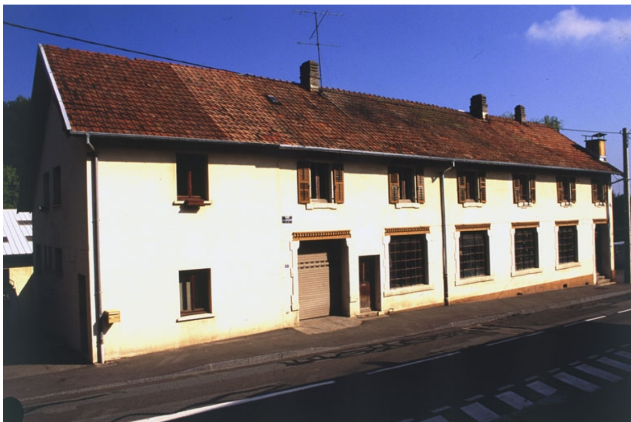
Façade sur rue de l'atelier de fabrication.
