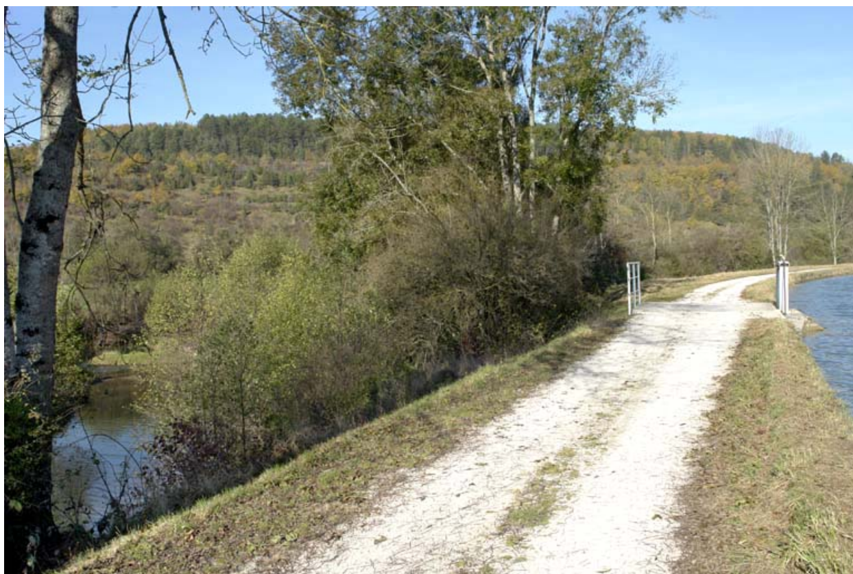
Le déversoir vu du chemin de halage.
