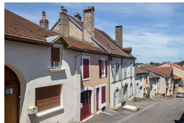
Vue d'ensemble des façades de la rive des numéros pairs de la rue Decaen, vers le nord-est. Phot. Jérôme Mongreville IVR43_20217000383NUC4A
