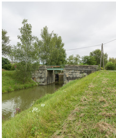
Vue d'ensemble du pont.
