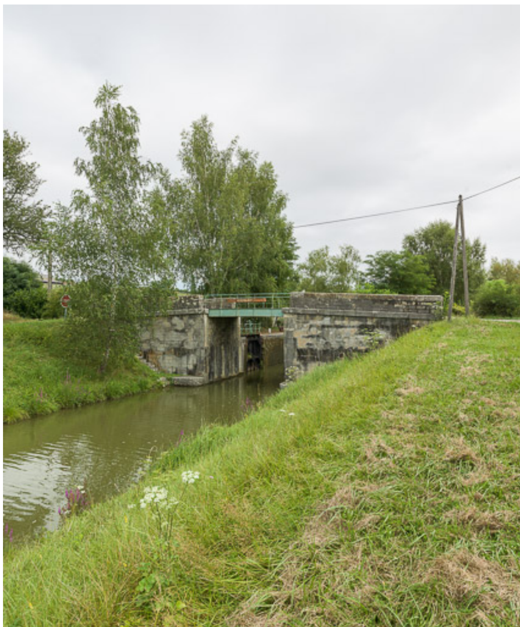
Vue d'ensemble du pont.
