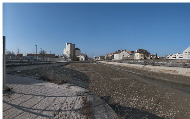
Port, vu d'aval. A l'arrière- plan à gauche : les minoteries dijonnaises, aujourd'hui détruites. Le bief est vide pour permettre la réfection du pont sur l'écluse 55.
