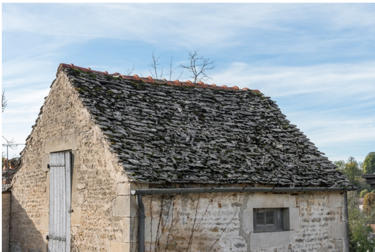
Détail de la toiture.
