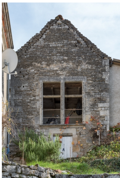
Vue du mur pignon nord. Phot. Pierre-Marie Barbe-Richaud IVR26_20222101095NUC4A
