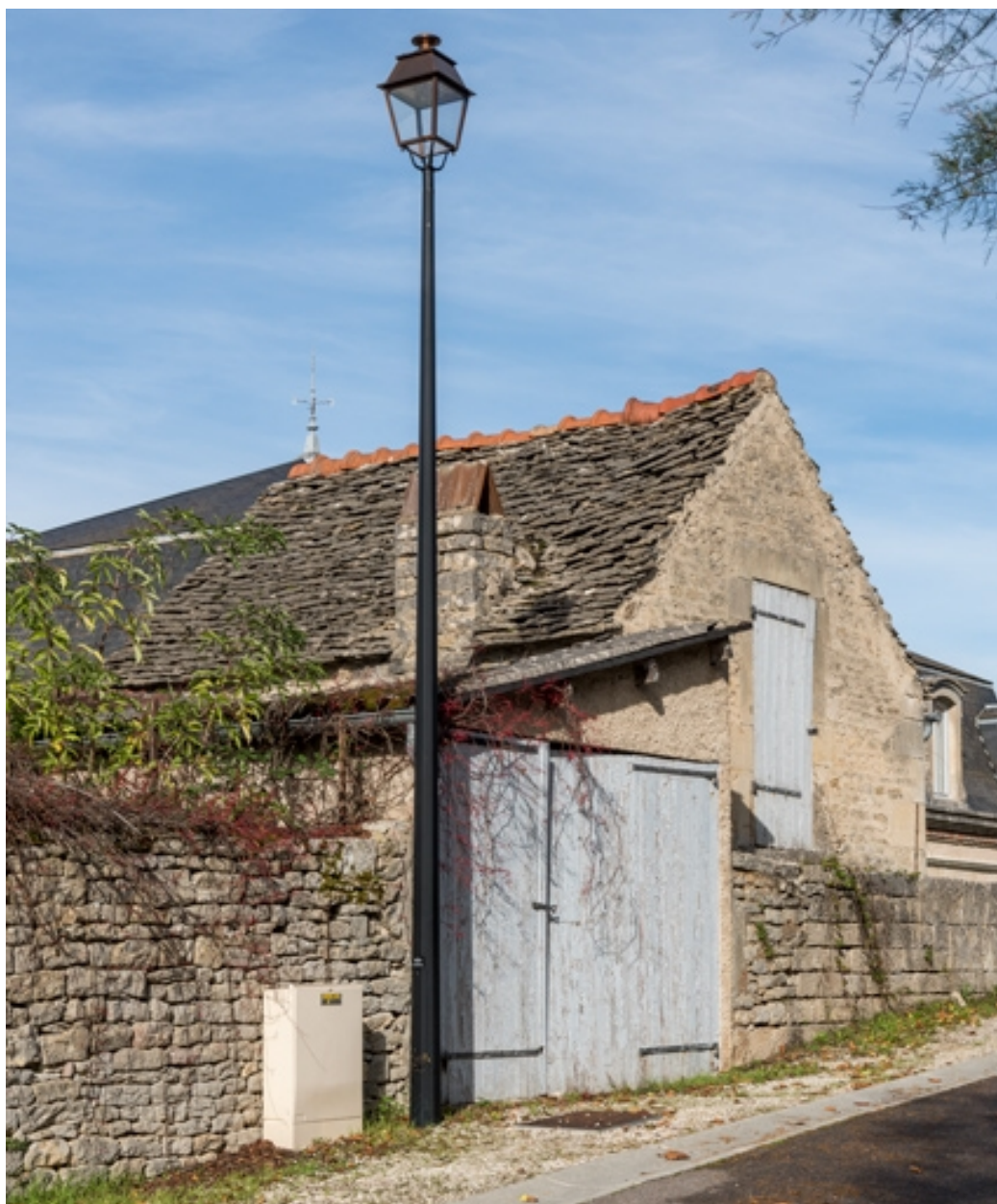
Vue d'ensemble depuis l'ouest.
