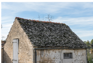
Détail de la toiture. Phot. Pierre-Marie Barbe-Richaud IVR26_20222101094NUC4A
