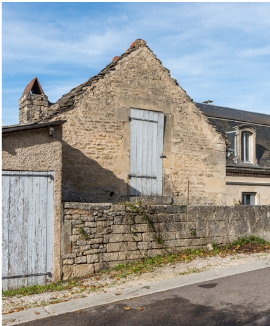
Détail du mur pignon sud.
