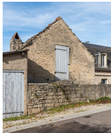
Détail du mur pignon sud. Phot. Pierre-Marie Barbe-Richaud IVR26_20222101092NUC2A
